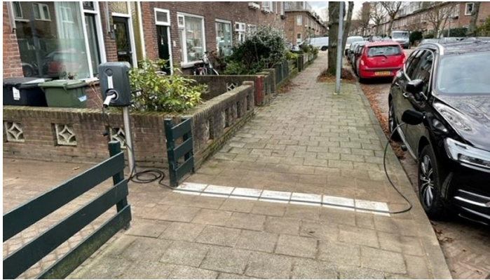
Figuur 1: Kabelgoottegels in de praktijk
