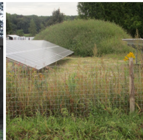
Afb. 33 Hekwerk met houten palen en schapengaas.
