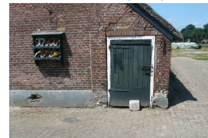
Achtergevel is in slechte staat, scheuren, voegwerk en scheve muren.
