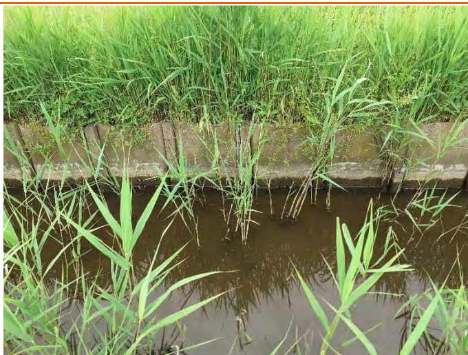
Asbestverdachte beschoeiing watergang 2
