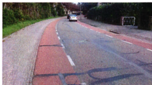
D (Slecht): weg is in slechte staat. Kleinschalig onderhoud is niet meer mogelijk en de weg dient z.s.m. grootschalig opgeknapt te worden. Kenmerk: veel schades zichtbaar over het complete wegdek, craquelé, scheurvulling, verzakkingen. Kleinschalige reparaties zijn vaak niet meer uitvoerbaar en de weg moet op korte termijn grootschalig opgeknapt worden. Eventuele onveilige situaties provisorisch repareren.
