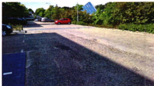
D (Slecht): weg is in slechte staat. Kleinschalig onderhoud is niet meer mogelijk en de weg dient z.s.m. grootschalig opgeknapt te worden. Kenmerk: veel schades zichtbaar over het complete wegdek, craquelé, scheurvulling, verzakkingen. Kleinschalige reparaties zijn vaak niet meer uitvoerbaar en de weg moet op korte termijn grootschalig opgeknapt worden. Eventuele onveilige situaties provisorisch repareren.
