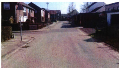
C (Matig): weg is in redelijk slechte staat. Met enkele kleinschalige of grootschalige reparaties kunnen onveilige situaties verholpen/voorkomen worden.
