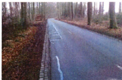
kenmerk: schades zichtbaar (reparatievakken, scheurvulling, slechte markering) die nu nog geen onveilige situaties opleveren, maar wel op redelijke termijn opgepakt moeten worden. Eventuele onveilige situaties plaatselijk repareren.
