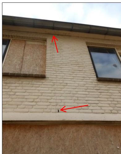
Afbeelding 3. Mogelijkheden voor vleermuizen om toegang tot de spouwmuur te krijgen (foto: Aveco de Bondt, 2014).
