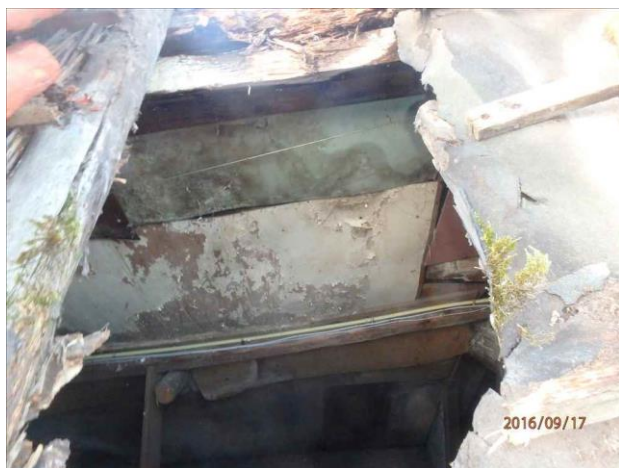
F11: verwijderde rookgaskanalen dak van woning
