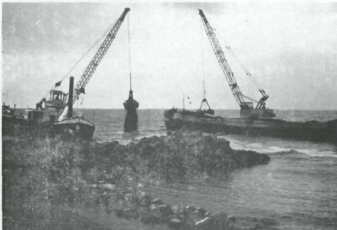
Foto 1. Aanbrengen onderste zandlaag.
