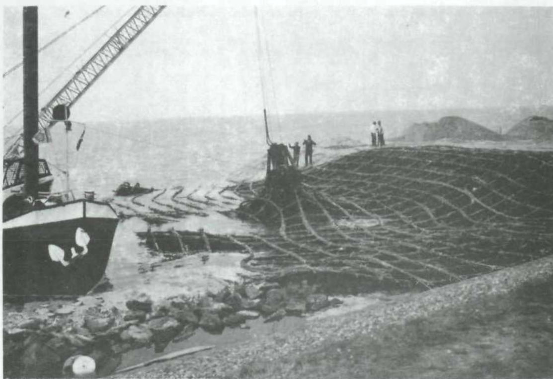
Foto 3. Aanbrengen filterdoek en wiepen.
