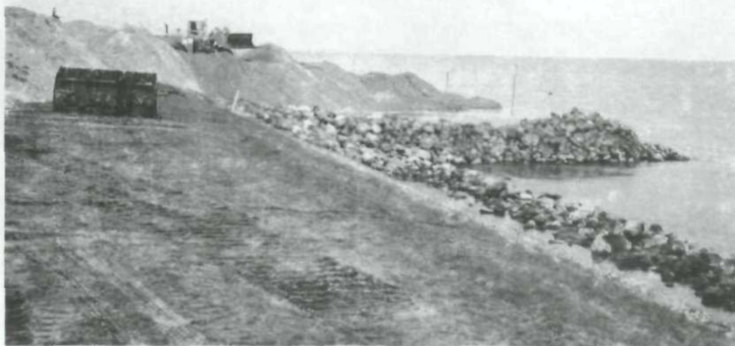
Foto 2. Aanbrengen bovenste zandlaag m.b.v. laadschop.
