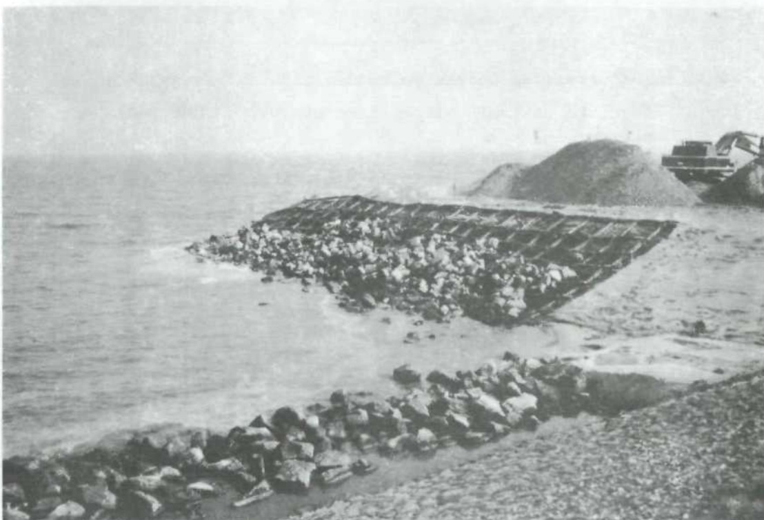
Foto 4. Aanbrengen stortsteen.
