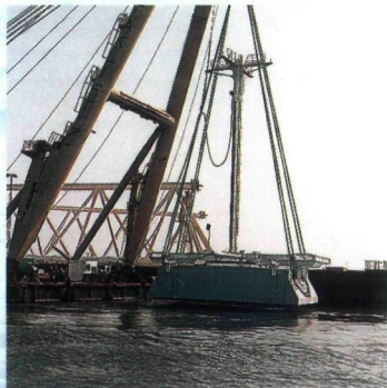
Plaatsing drempelblokken
