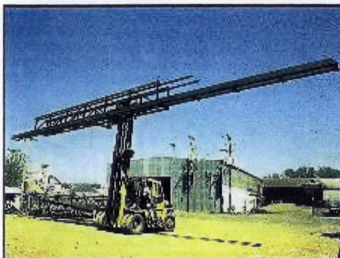
Figuur 8 Baanelementen worden met vorkheftruc op hun plaats gebracht
