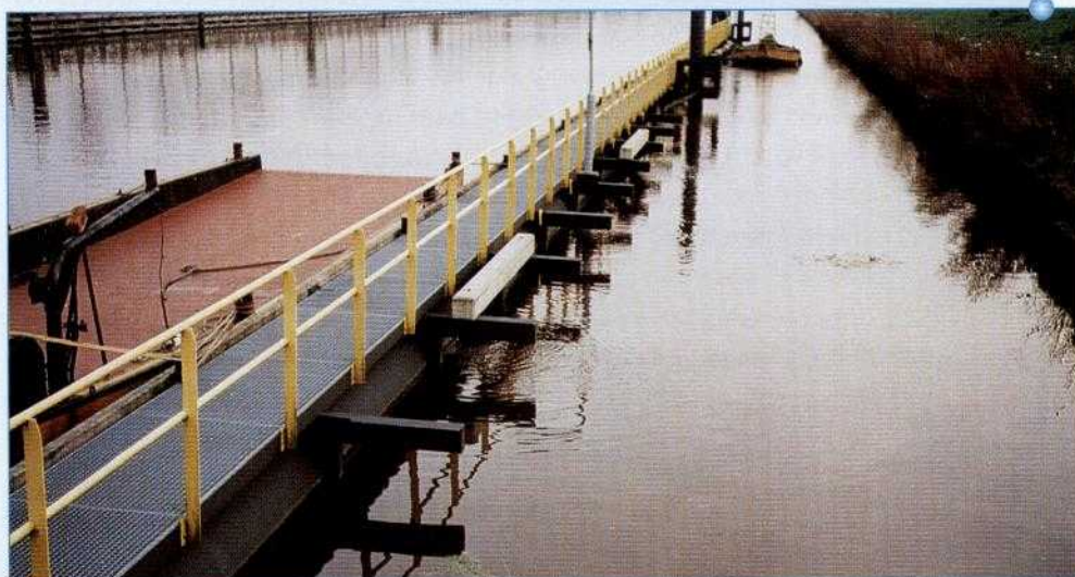
Sectie 4 van het drijvend remmingwerk bij schutsluis Engelen met door ijs scheefgedrukte geleidepalen.
