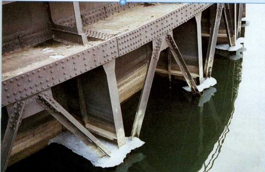
Aan de open-constructiezijde van het zuidelijke vizier van het stuwcomplex Amerongen is nagenoeg geen ijsvorming.
