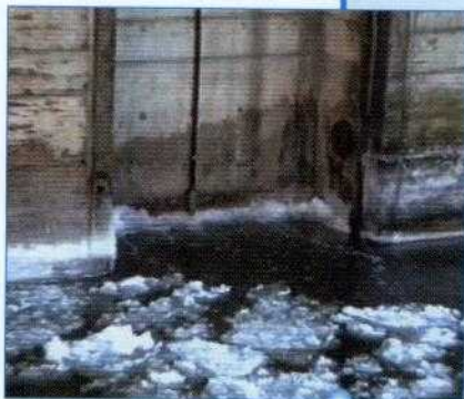
Ijs voor een roldeurnis van de Krammersluizen bij -15^{\circ}\text{C} .
