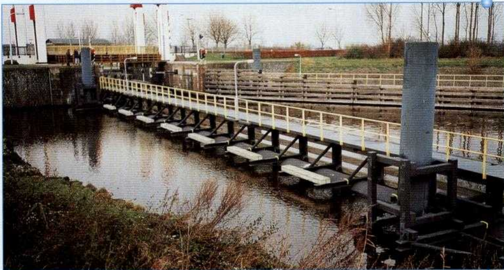
Sectie 2 van het drijvend remmingwerk bij de schutsluis Engelen met door ijs scheefgedrukte geleidepalen.
