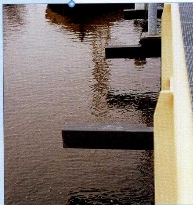
De belletjes in het water duiden op een whirlscherm in werking bij de schutsluis Engelen.
