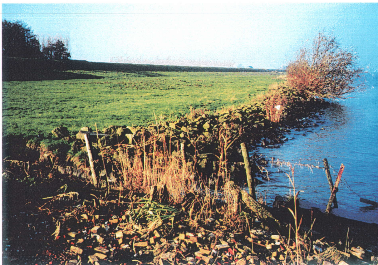
Figuur 2 Plaatselijk is ook zeildoek en puin gebruikt als oeververdediging
