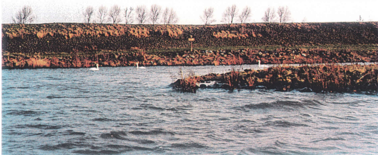
Figuur 6 Dijkbekleding (zetsteen) bij voormalige dijkdoorbraak (1953)
