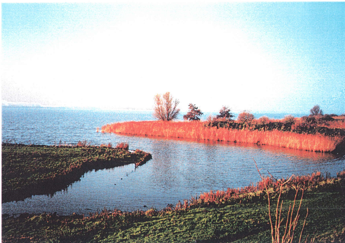
Figuur 7 Bij de voormalige dijkdoorbraak (1953) kan de golfaanval aanzienlijk zijn door het voorgelegen open water
