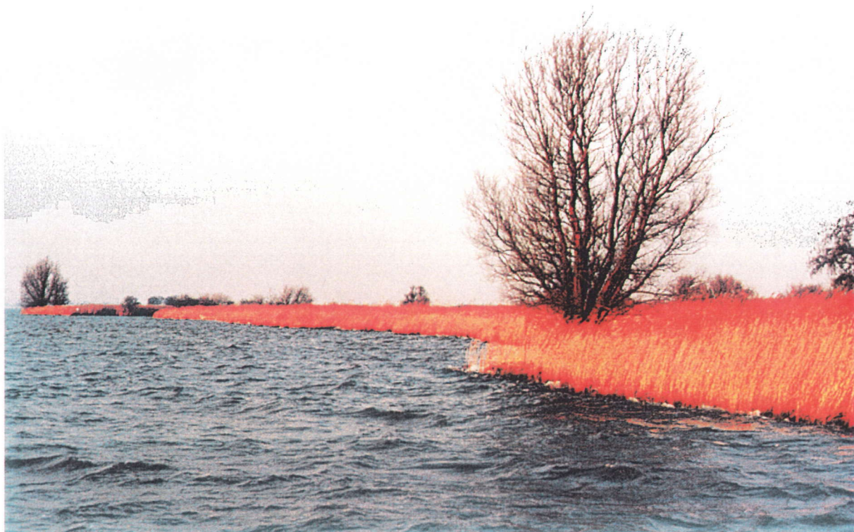
Figuur 8 Er is duidelijk onderscheid tussen locaties waar de vooroeververdediging en rietkraag nog intact is, en naastgelegen stukken waar de rietkraag aanzienlijk smaller is
