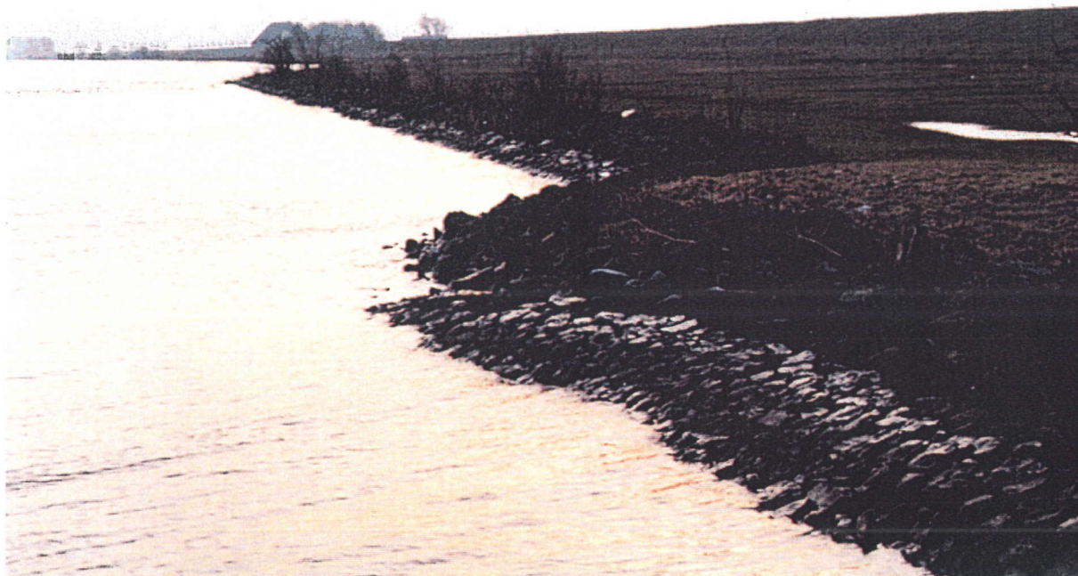
Figuur 1 Karakteristieke oeververdediging bestaande uit zetsteen en stortsteen
