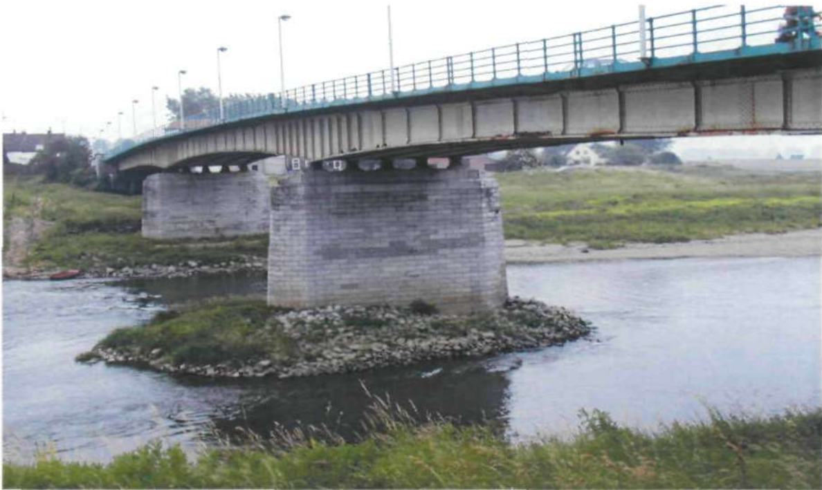
Foto 4.11 Detail van brugpijler, bodemverdediging rond pijler en begroeiing
