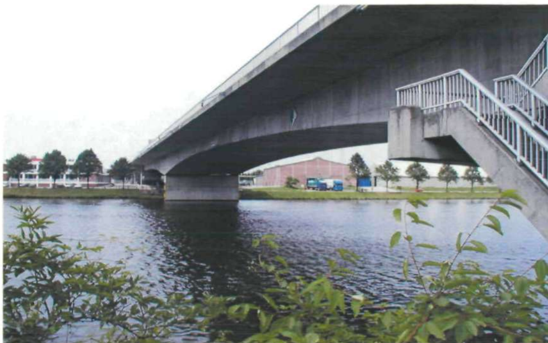
Foto 4.3 De Noorderbrug in Maastricht met rechterpijler in de oever en de linkerpijler in het zomerbed, ongeveer 19 meter uit de oever. Het water stroomt van west naar oost
