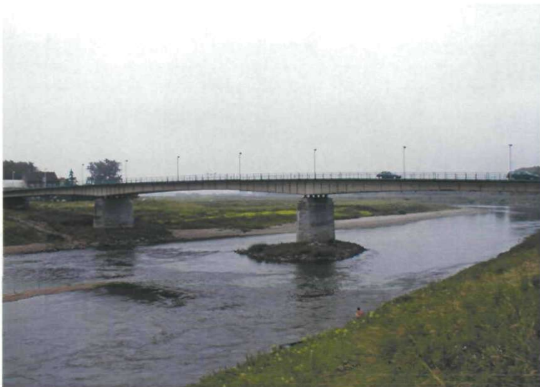
Foto 4.9 De brug in Maaseik met pijler en eiland benedenstrooms van de pijler. Het water stroomt van noord-oost naar zuid-west.
