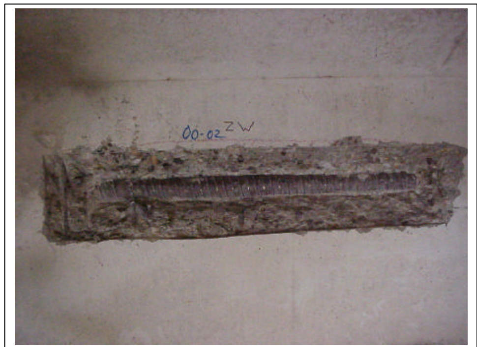
Figuur 4.2 Sleuf in zijkant van een koker tot aan een voorspankanaal
