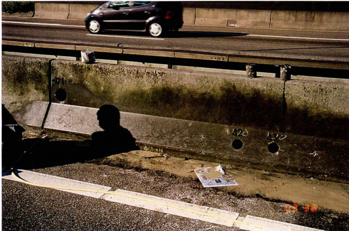
Foto 13: Rijbanen in noordelijke richting, middenberm, profiel 3, locatie kernen B-2416 K41, K42 en K43.
