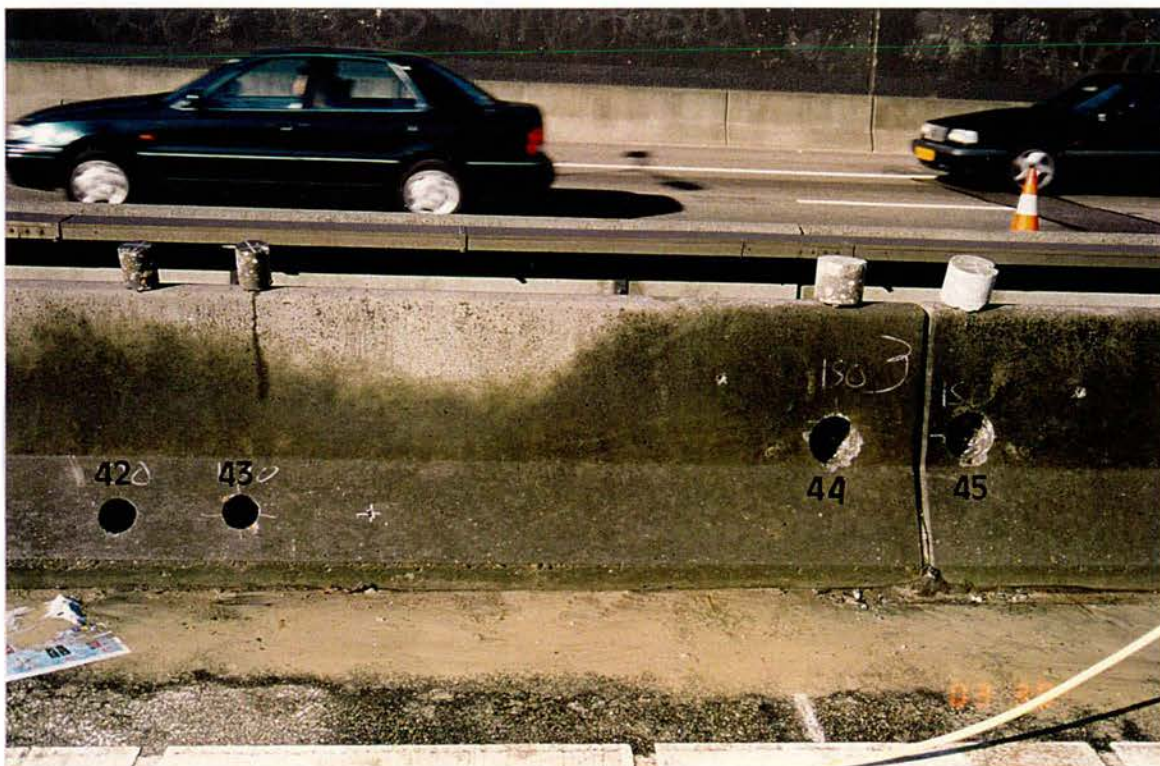
Foto 14: Rijbanen in noordelijke richting, middenberm, profielen 3 en 4, locatie kernen B-2416 K42, K43, K44 en K45.
