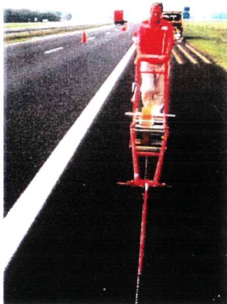
Foto 3 Aanbrengen van markeringsstroken met de tape-applicator
