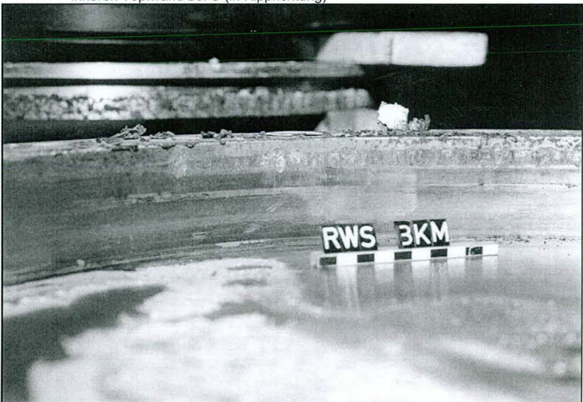
Abb. 9.16: Lagertopf nach Ausbau des Elastomerkissens: Kontaktflächen des Deckelbunds und der UHMWPE-Innendichtung an der inneren Topfwand bei C (in Kipprichtung)
