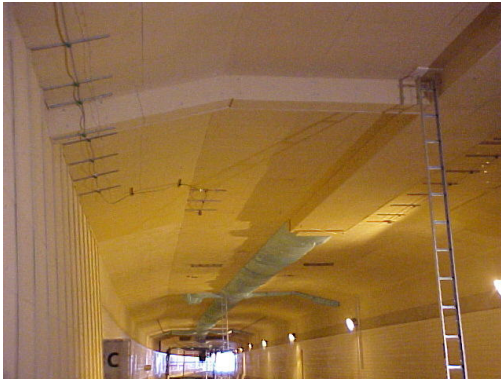
Ophanging kabels, dwarskoof en koof in de lengterichting
