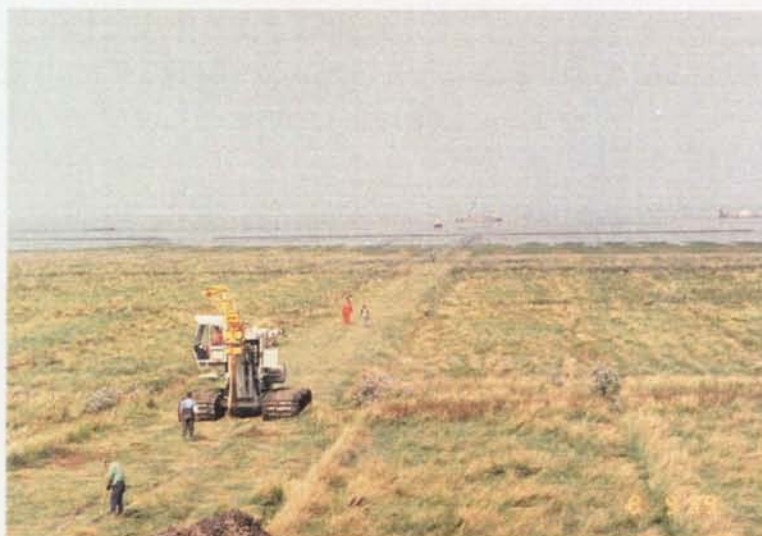
Aanleg van een glasvezelkabel naar Ameland door het kweldergebied oostelijk van de veerdam Holwerd
