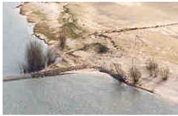
Figuur 3.10-b Herstel van achterloopse krib (Hurwenensche Waard, Waal km 928, Meetkundige Dienst 1995).
