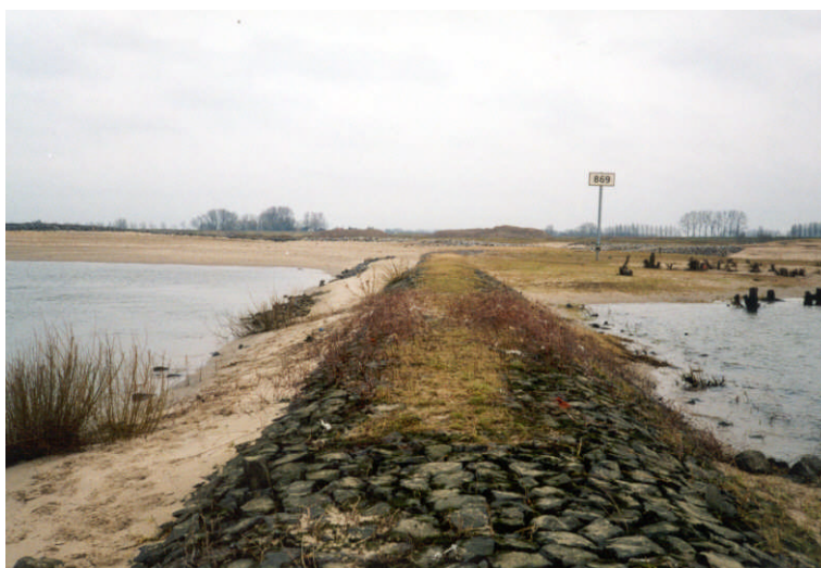
Figuur 6.1 Kribkruin met benedenstroomse sedimentatie na hoogwater (stroming van rechts naar links).
