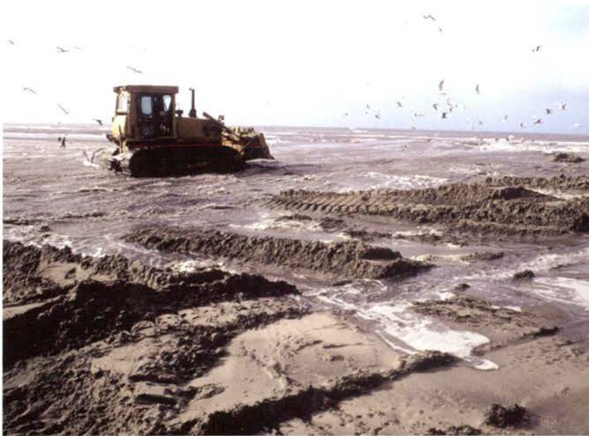
Figuur 5.12: suppletie in uitvoering
