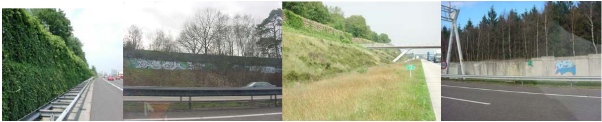
Figuur 3 Geluidswerende voorzieningen langs de A28
