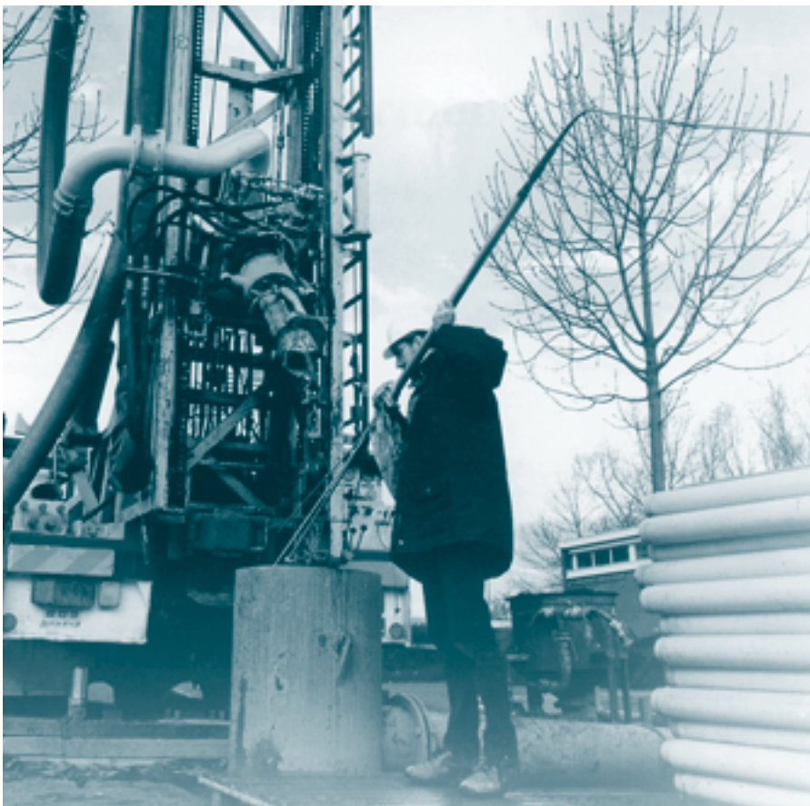
Figuur C.4 Het aanbrengen van de meetsonde voor boorgatmetingen in een verbuisd boorgat.
