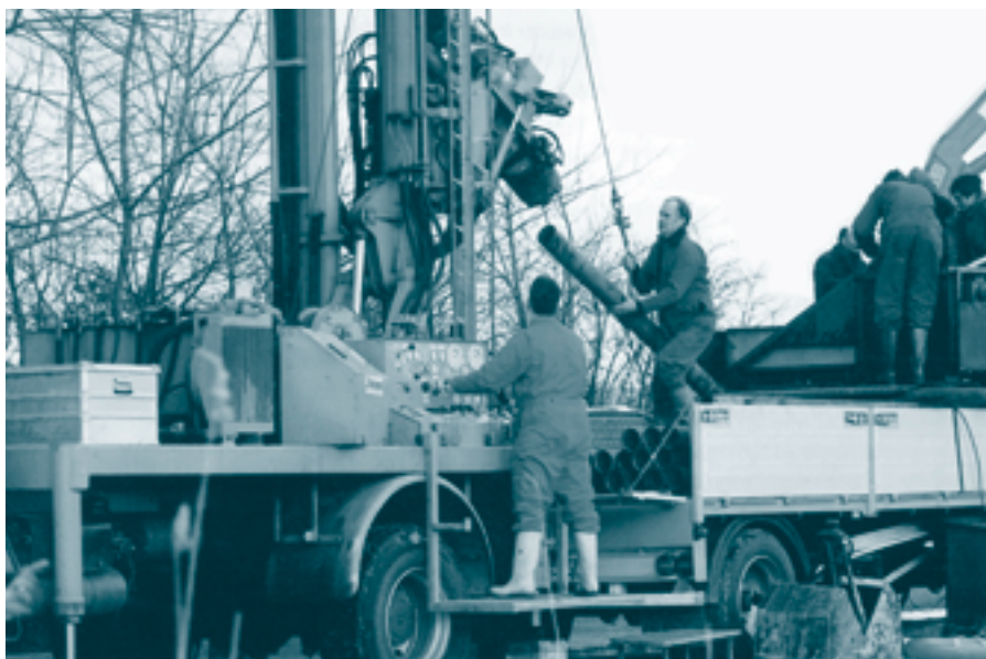
Figuur B.4 Het aanbrengen van de boorbuizen tijdens een counter flush boring.
