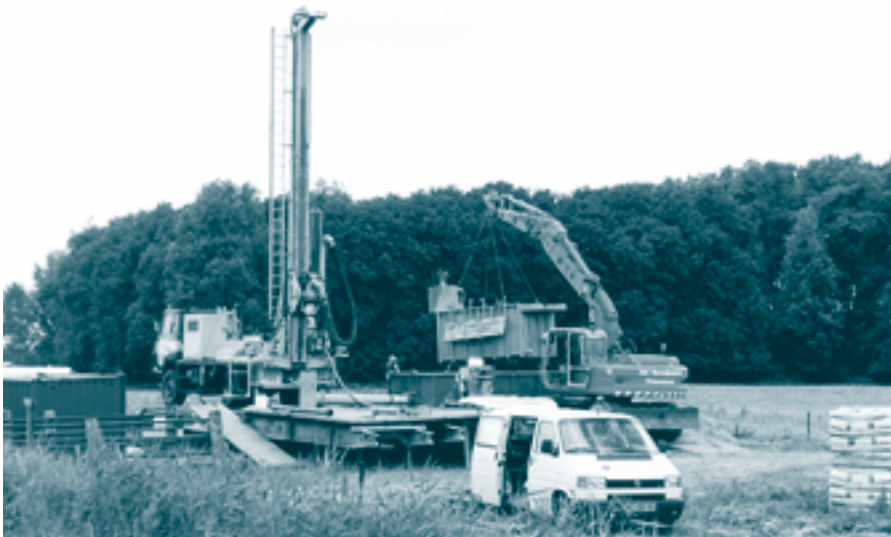
Figuur B.7 De uitvoering van een luchtliftboring in het terrein. Dit soort boringen vergt behoorlijk wat werkruimte en niet ieder terrein zal toegankelijk zijn voor dit soort zware voertuigen.
