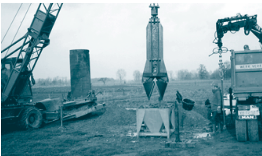
Figuur B.6 Een knijperboring die uitgevoerd werd bij de grove grindafzettingen in Limburg.
