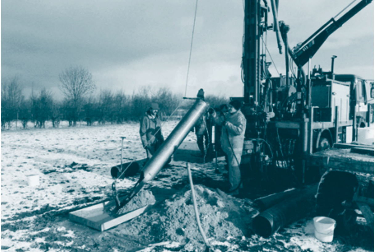
Figuur 4.2 Monstername bij een puls boring, de puls wordt hiertoe buiten het boorgat gelegd.
