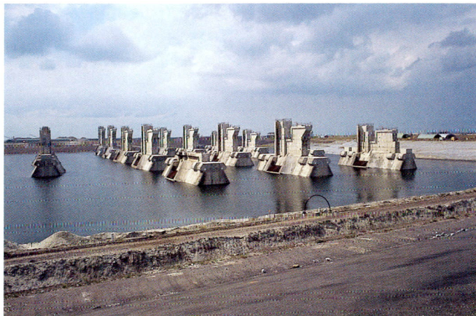
Seriebouw bij pijlerconstructie.
