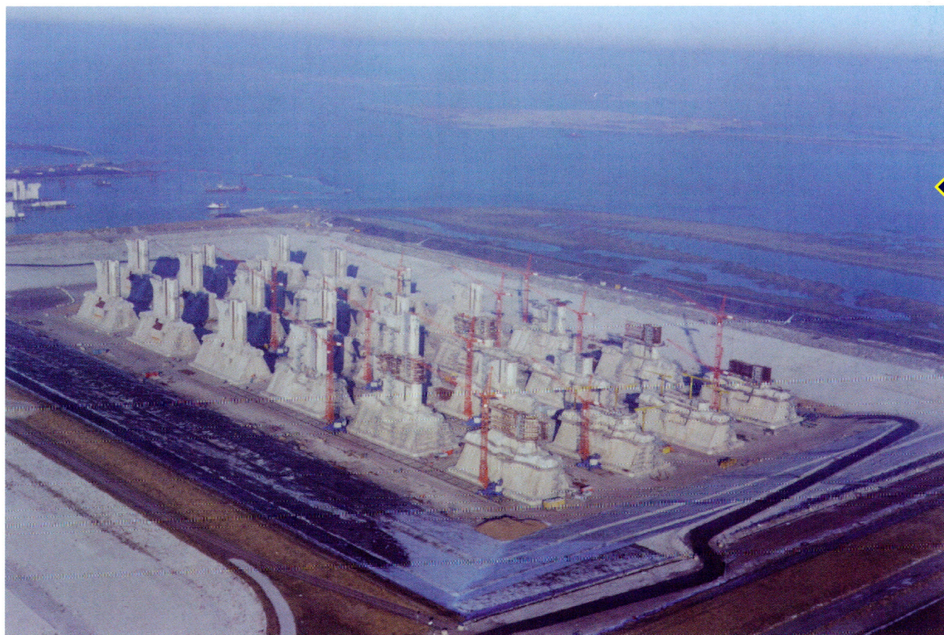
Seriebouw bij pijlerconstructie.
