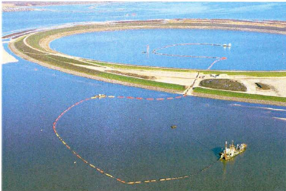
Abbildung 4-13: Beispiel für hydraulisches Einleiten in ein eingedeichtes Depot (IJsseloog-Depot, 1999)
