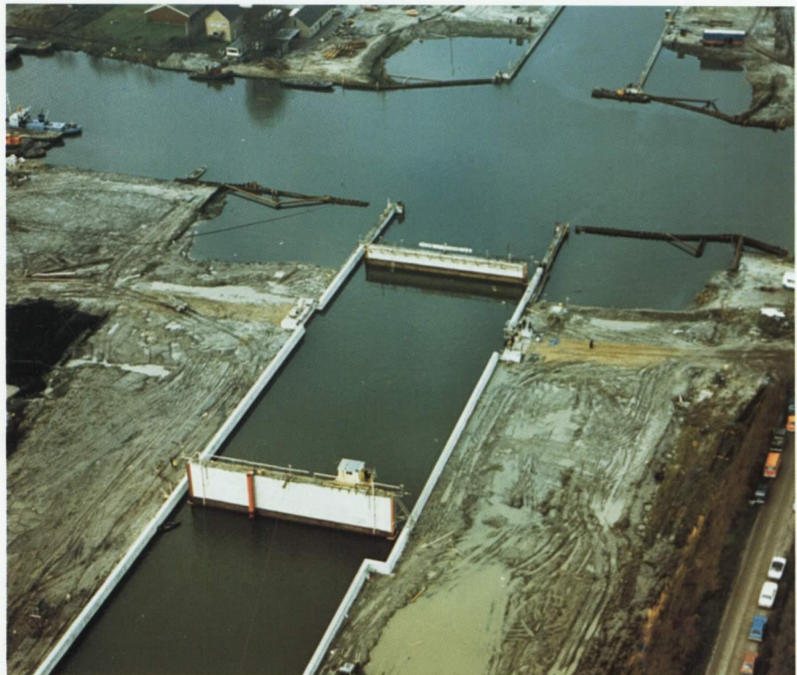
Bouwmethode Amsterdam-Rijnkanaal; opdrijven tunnel-element in bouwkuip
