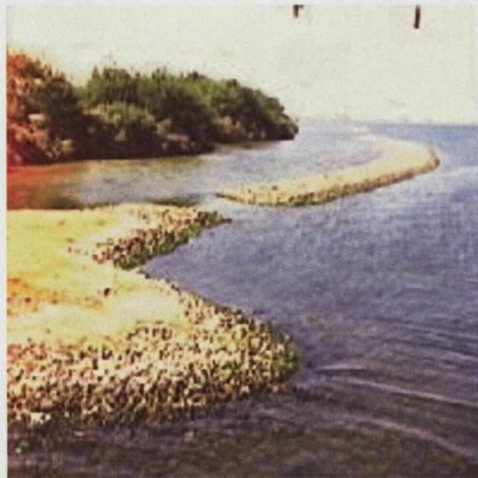
Figuur 3a: Foto van vooroeververdediging met een doorstoomopening en tussen de oever en de verdediging de natte zone.
