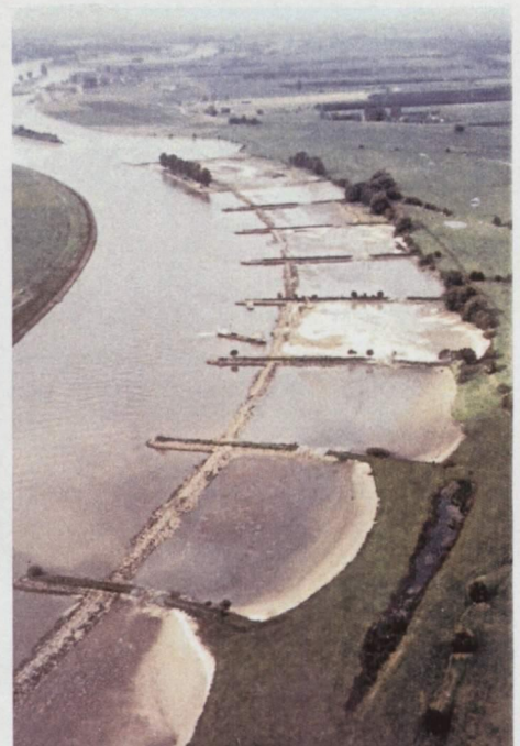
Figuur 3b: Foto van kribben met daartussen gelegen strekdammen.
