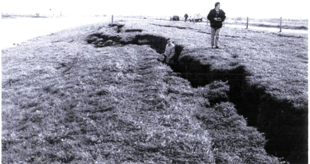
Foto 1 Scheuren in de Maasdijk bij Asselt als gevolg van de beving bij Roermond op 13 april 1992 (Rijkswaterstaat)
