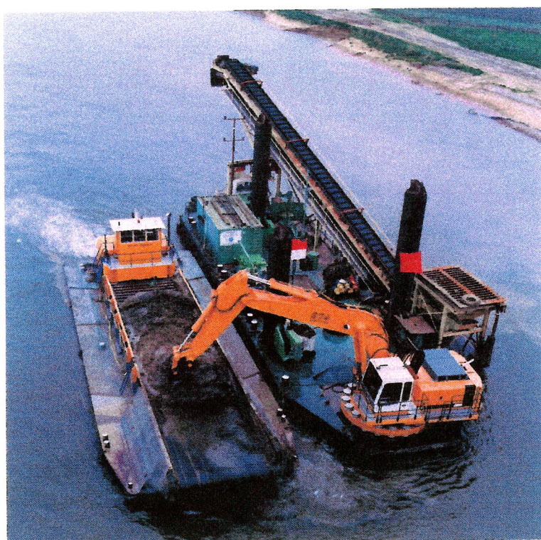
Figuur 5: Ontgraven schone niet vermarktbaar grond door kraanponton "Durme" en laden van koplosser in vak J t.b.v. de afdeklaag geconcentreerde berging
