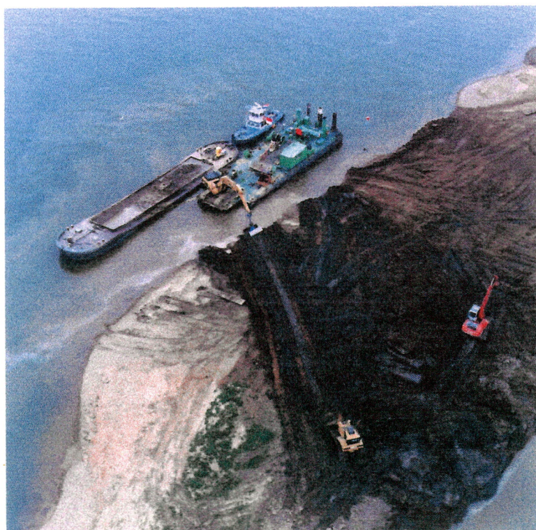
Figuur 7: Ontgraven, omzetten van deelpartij 2 in vak R en laden door kraanpontoon "Europa" van de langsijz liggende splijtbak
