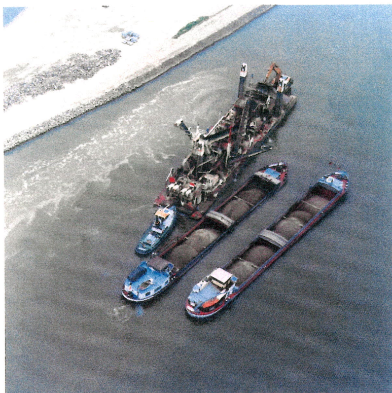
Figuur 6: Ontgraven en verwerken van schone vermarktbare grond in twee verschillende fracties door de "Samson" in vak G
