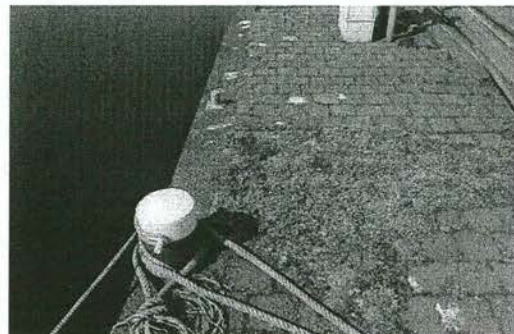
foto 2: Licht gecorrodeerde deksloof
