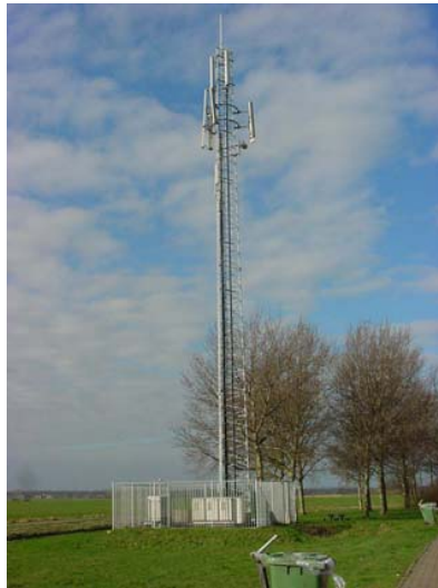
Figuur 7 GSM-mast met open vakwerkconstructie
