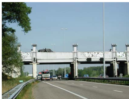
Figuur 5 Schuifconstructie in de Diefdijk
