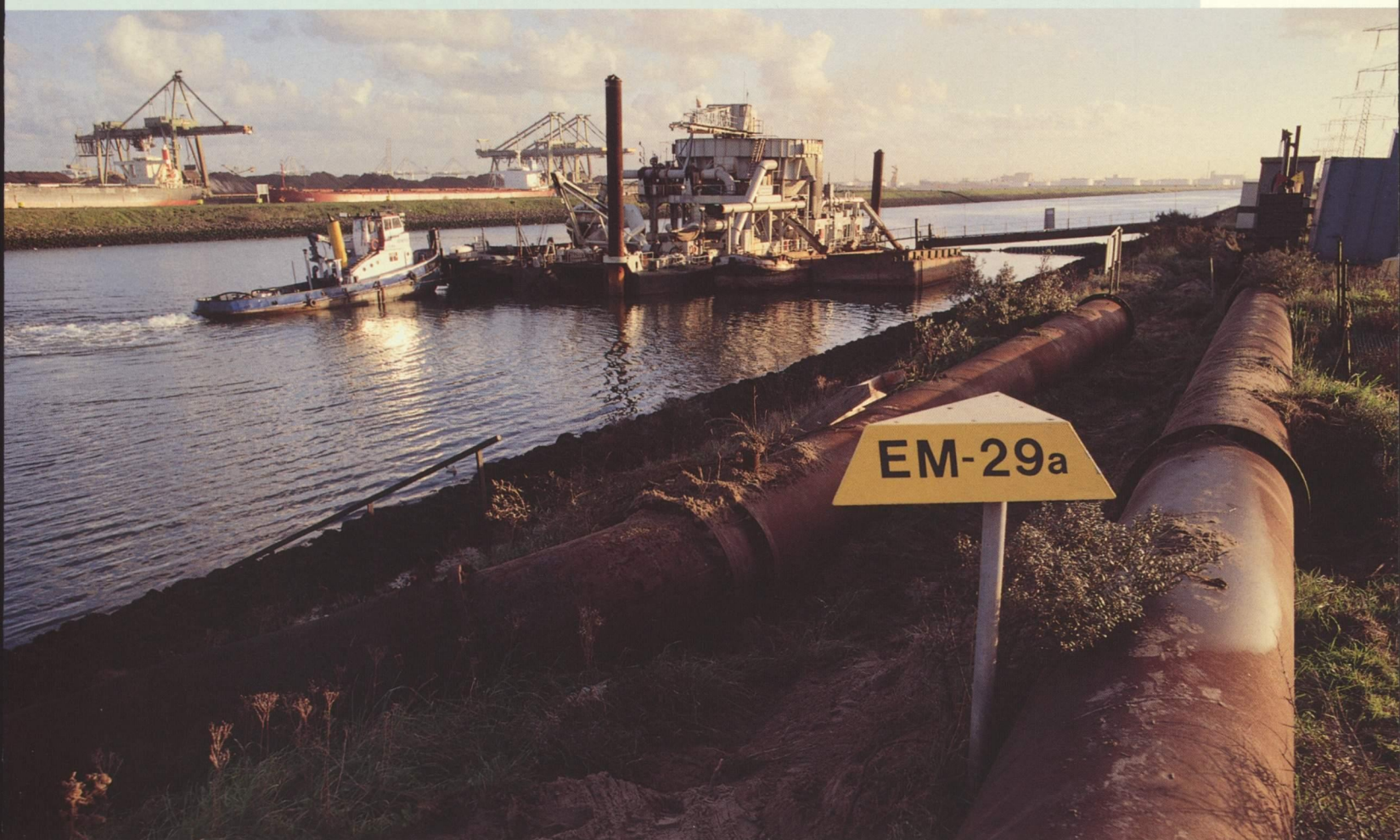
In het Hartelkanaal worden de bakken met baggerspecie gelost
