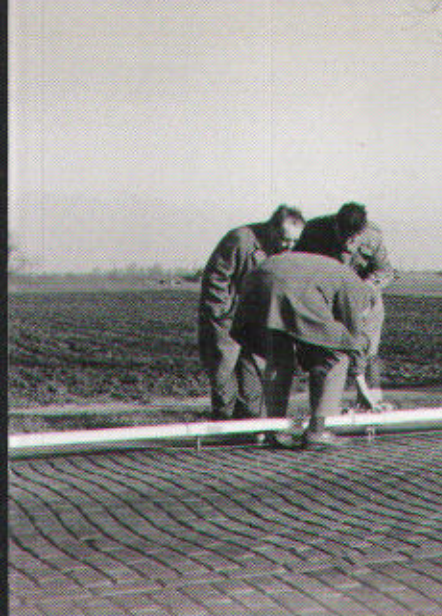
Meting van vlakheid door middel van "de Rij"
