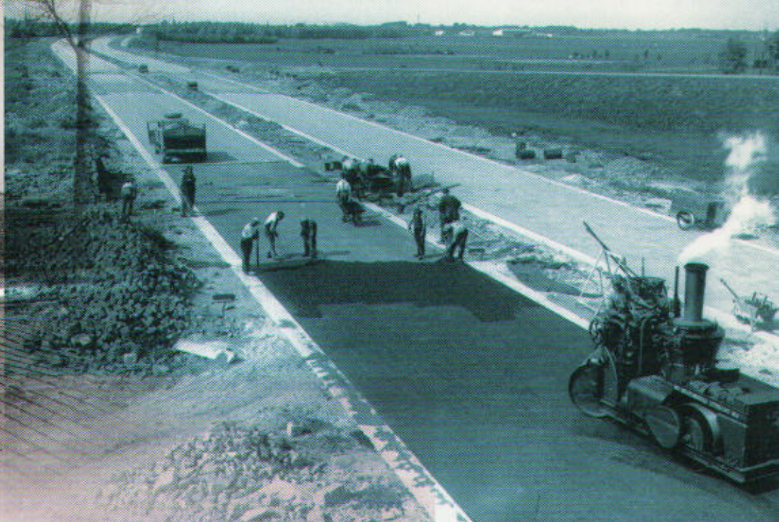
Meting van vlakheid door middel van "de Rij"
