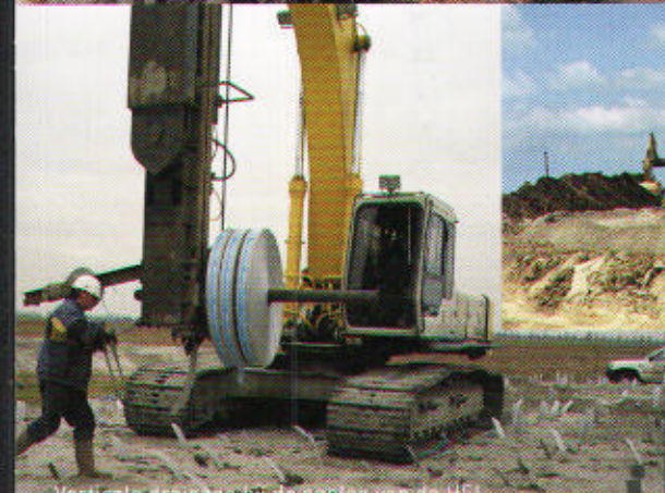
Verticale drainage bij de aanleg van de HSL
