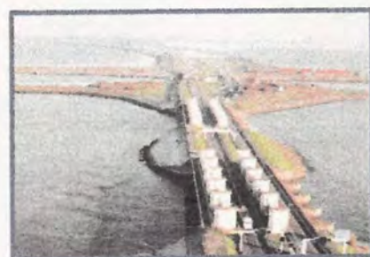
Het duizendcomplex in de Afsluitdijk bij Kornwerderdijk. Hierdoor stroomt water van de IJssel de Waddenzee binnen.
