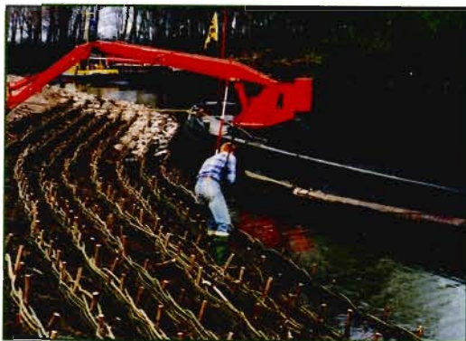
Afdekking met rijbeslag, deels bestort met breuksteen
