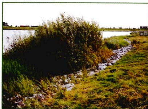
Situatie na aanleg, doorgroeibare verdediging langs het Spui
