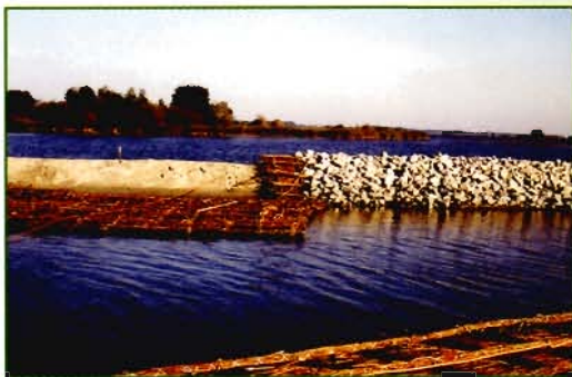
Aanleg vooroeververdediging bij de Boerenplaat
