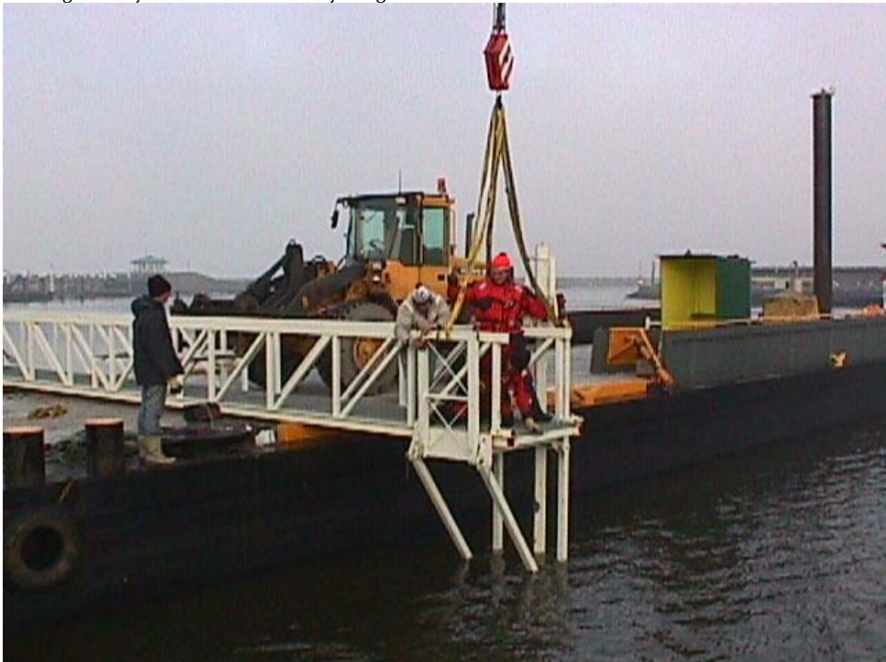
Foto 2.2: De meetbrug op het ponton tijdens het verplaatsen van koker 4 naar koker 5.
