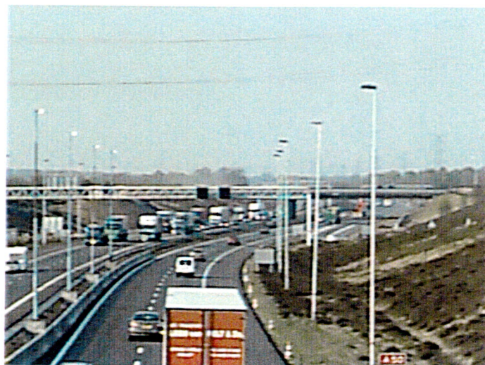
In de middenberm OV proef verlichting, rechts de werkverlichting, die tijdens de proef was uitgeschakeld (foto)
