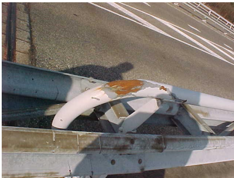
Figuur 6-2 Schadenummer 12: Leuningregel is vervormd, conservering bladdert (Inspectierapport [4.])
