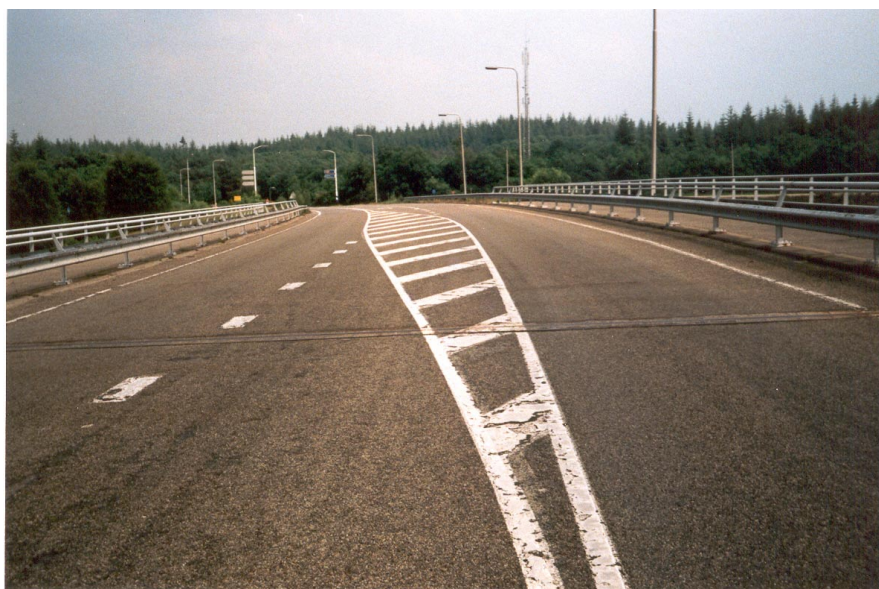
Figuur 4-1 Deklaag van DAB op viaduct Keizersveld
