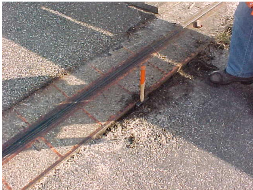
Figuur 6-1 Schadenummer 1: aansluiting asfalt t.p.v. fietspad (Inspectierapport [4.])
