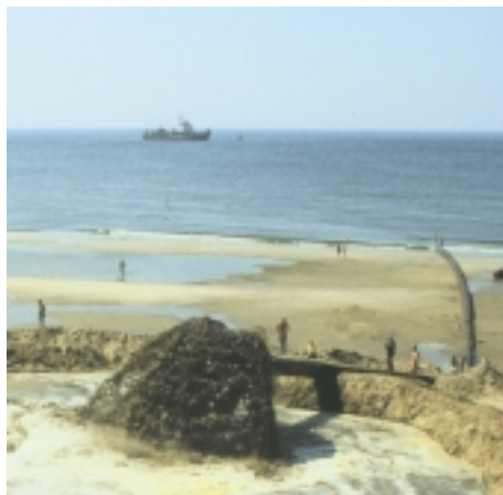
Zandsuppletie; dit gebeurt voor die delen van de kust, waar met oog op de veiligheid de kustlijn gehandhaafd moet worden (Foto:RIKZ).
