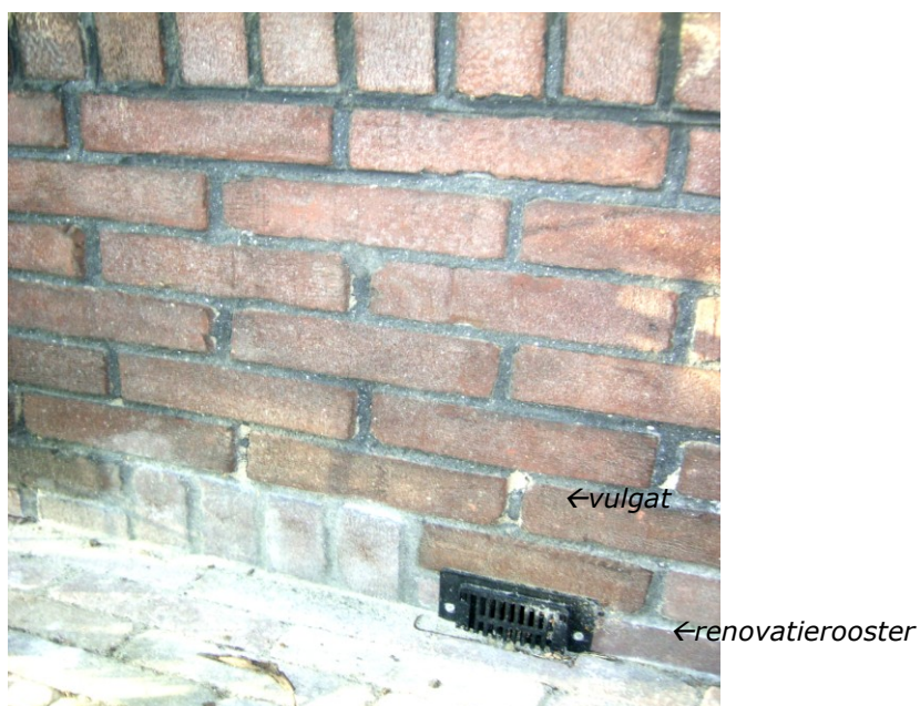
Figuur 6.2 Herkenning van na-isolatie spouwmuur (Vulgaten ongeveer 1 cm rond, renovatierooster vervangt oorspronkelijke open voegen). Foto: Onno van Rijsbergen.
