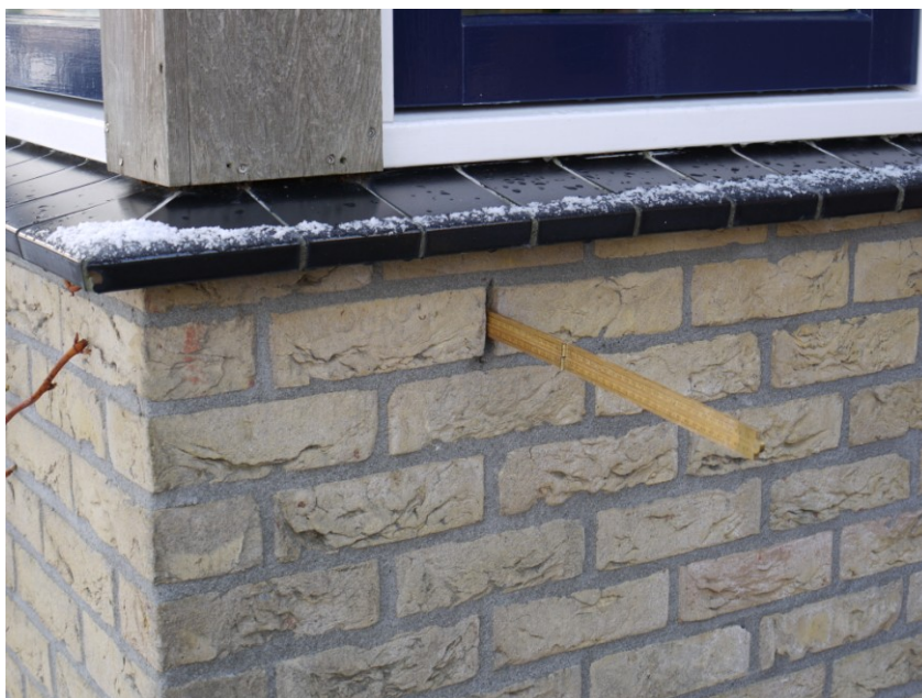
Figuur 6.1 Onderzoeken van spouwisolatie door met een meetlat via een open stootvoeg te voelen en te luisteren.
