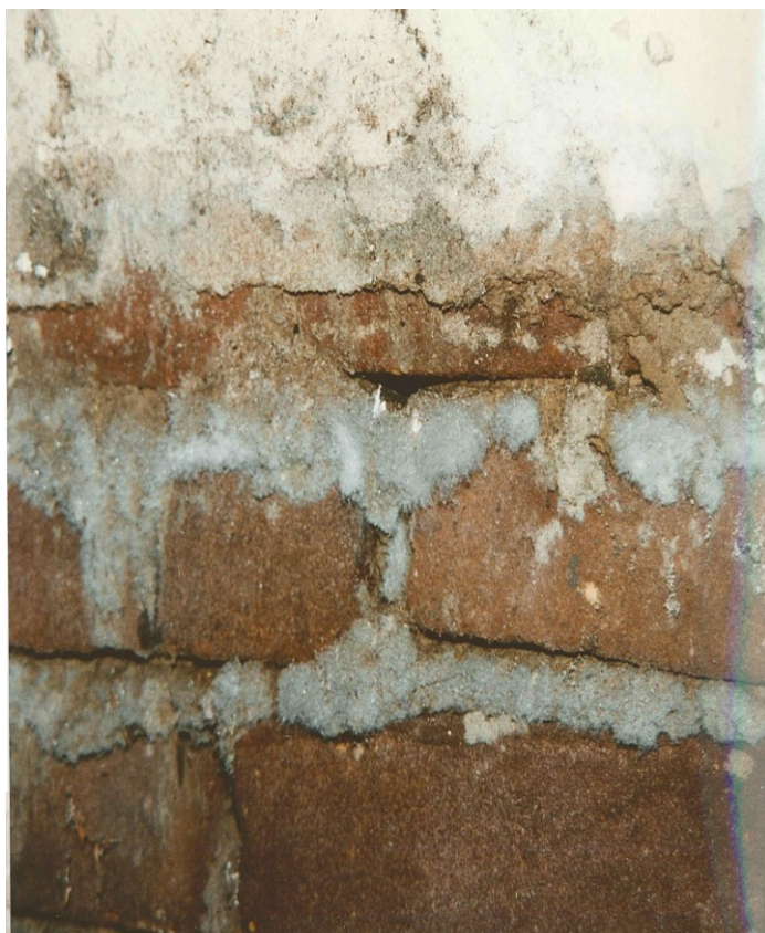
Figuur 3.6 Een voorbeeld van zoutuitbloei (foto Ruud van Schie)
