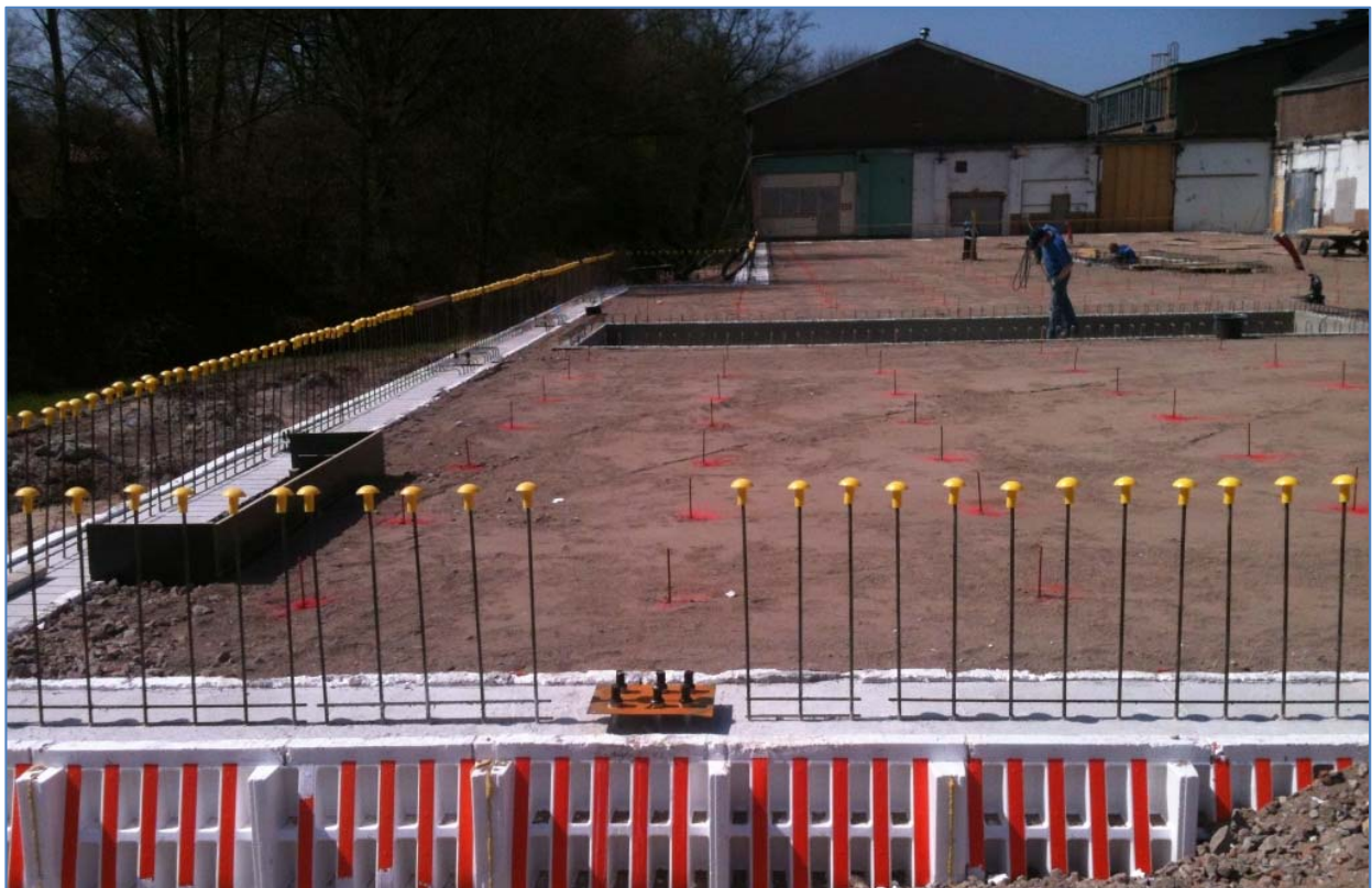
Foto 6: Situatie met funderingsbalken en machine fundaties
