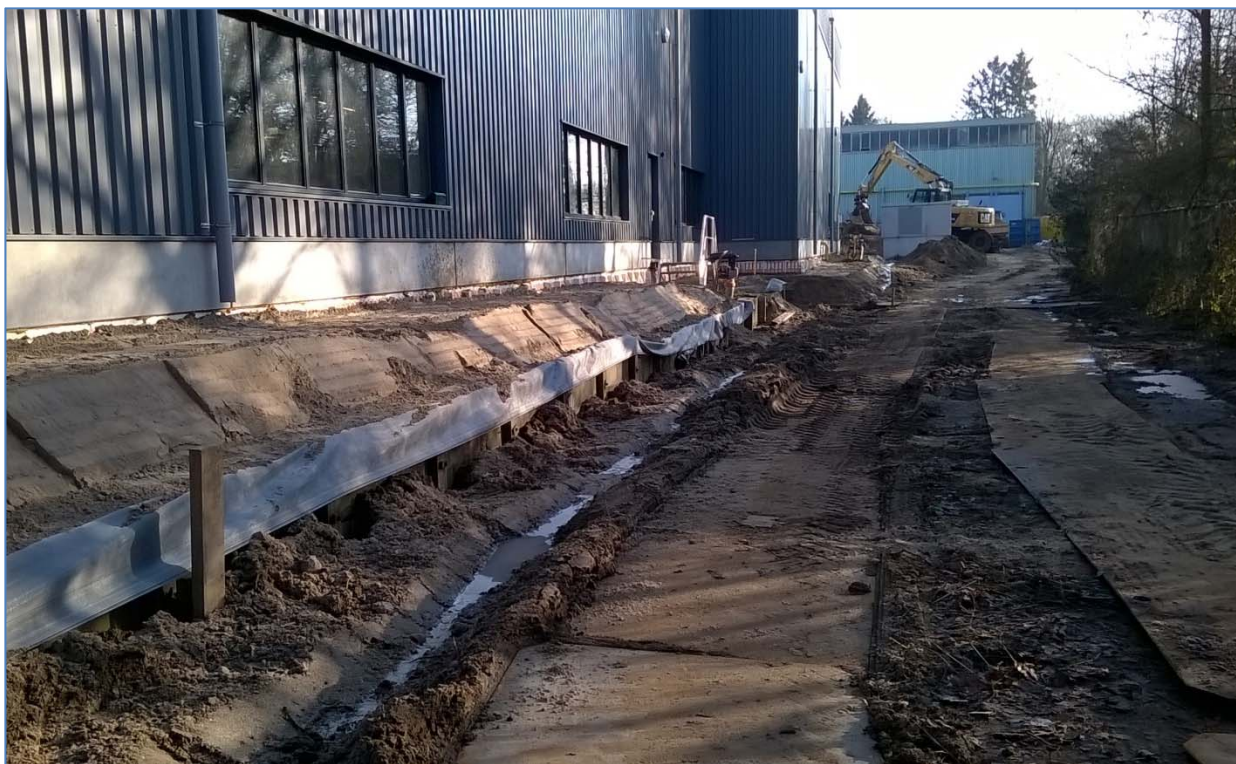
Foto 7: Afwerking maaiveld met kleigrond op doek langs Dorpsebeek
