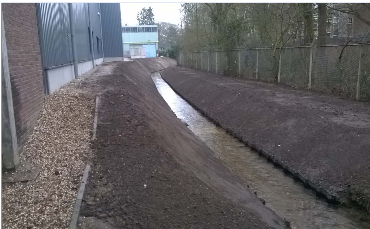
Foto 8: Situatie Dorpsebeek met afgewerkte taluds en maaiveld
