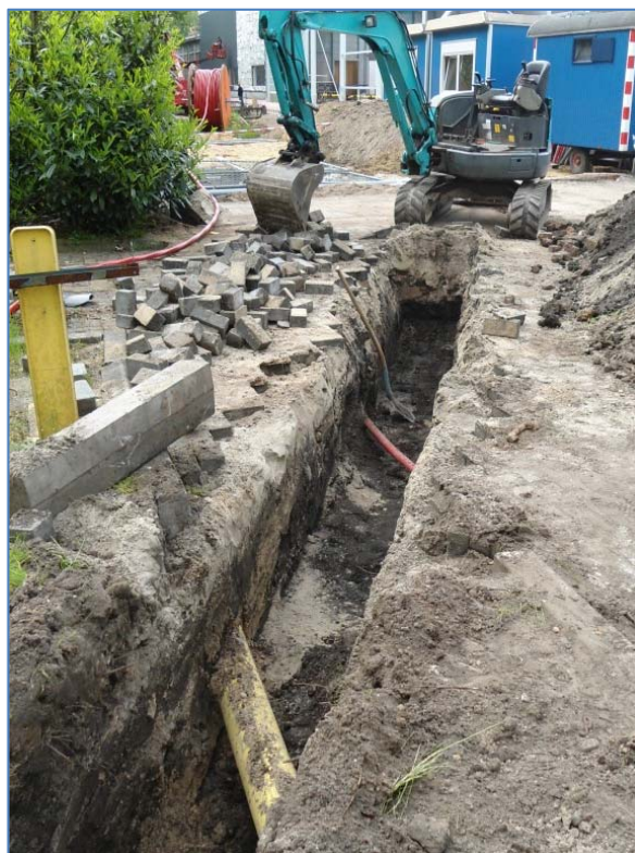
Foto 4: Kabel- en leidingsleuf
