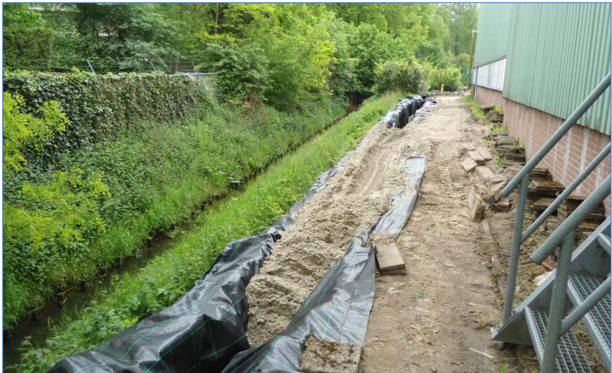
Foto 5: Kabel- en leidingsleuf met geotextiel en zandaanvulling
