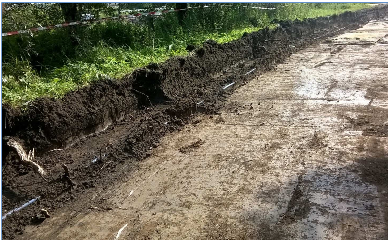
Foto 1: Wand en bodem ontgraven wegcunet
