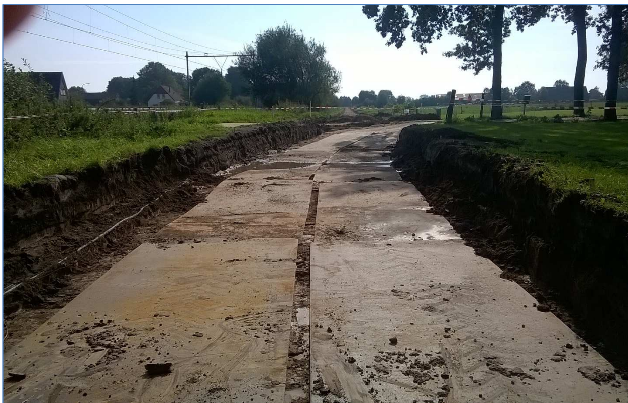
Foto 2: Ontgraven wegcunet met tijdelijke rijplaten
