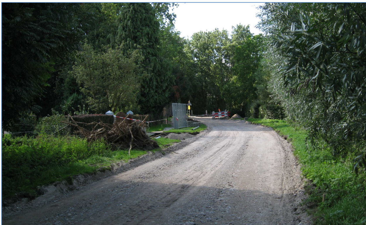
Foto 3: Aangebracht menggranulaat wegcunet
