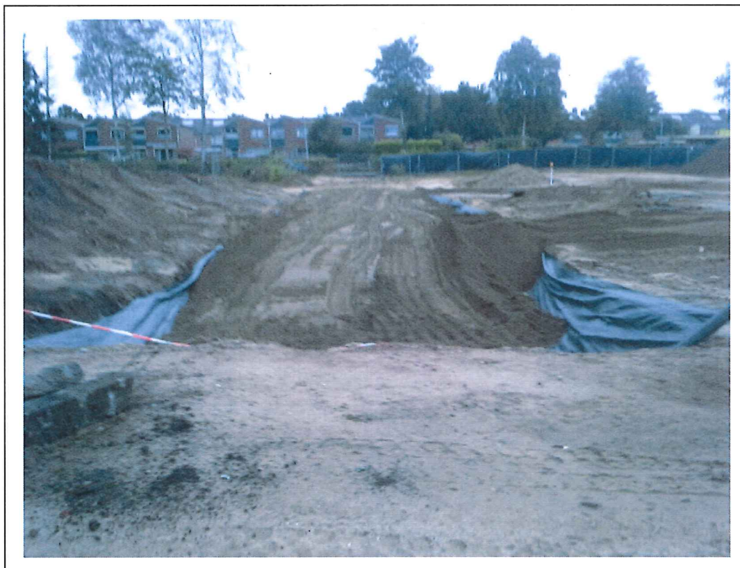
Foto 2. Wegcunet t.p.v. de stort, volledig afgewerkt met folie en eerste deel van de leeflaag
