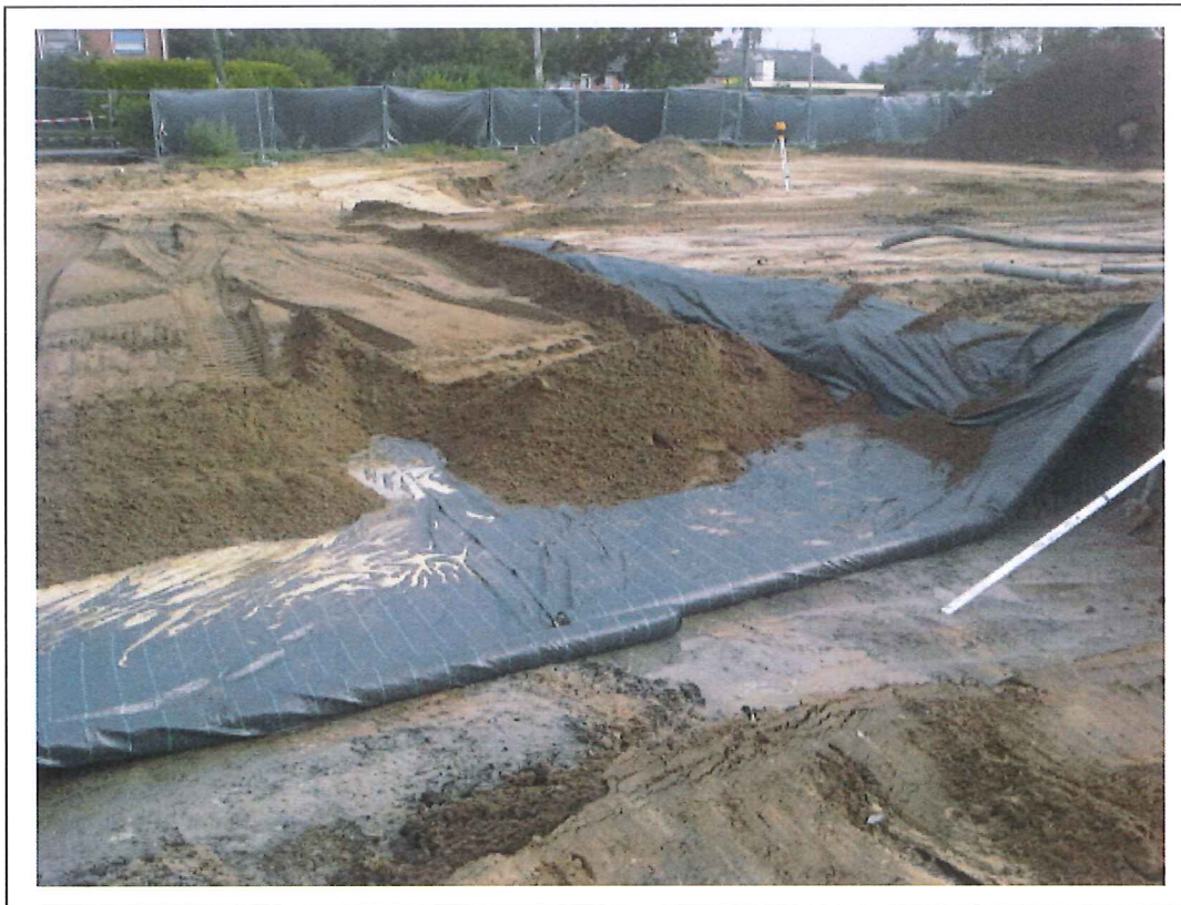
Foto 1. Aanbrengen folie en eerste deel van de leeflaag op het stortmateriaal
