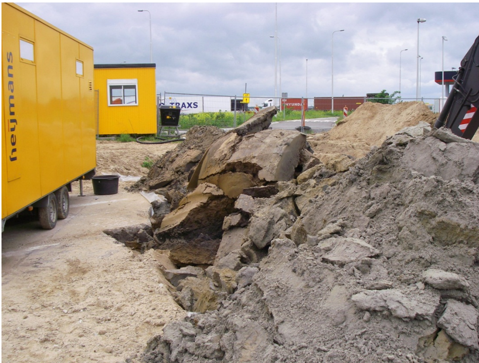
Afbeelding 3 laagsgewijs in depot geplaatste grond
