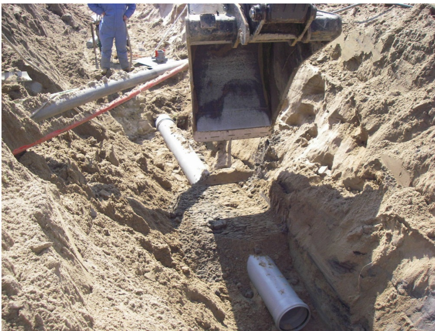
Afbeelding 2 Aanleg riool
