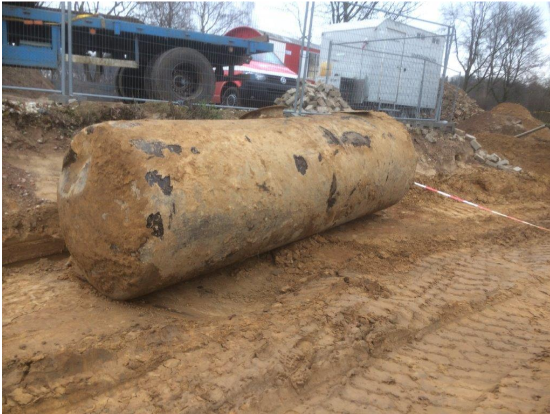
Foto 11: Uitgegraven ondergrondse tank, 5000 l
