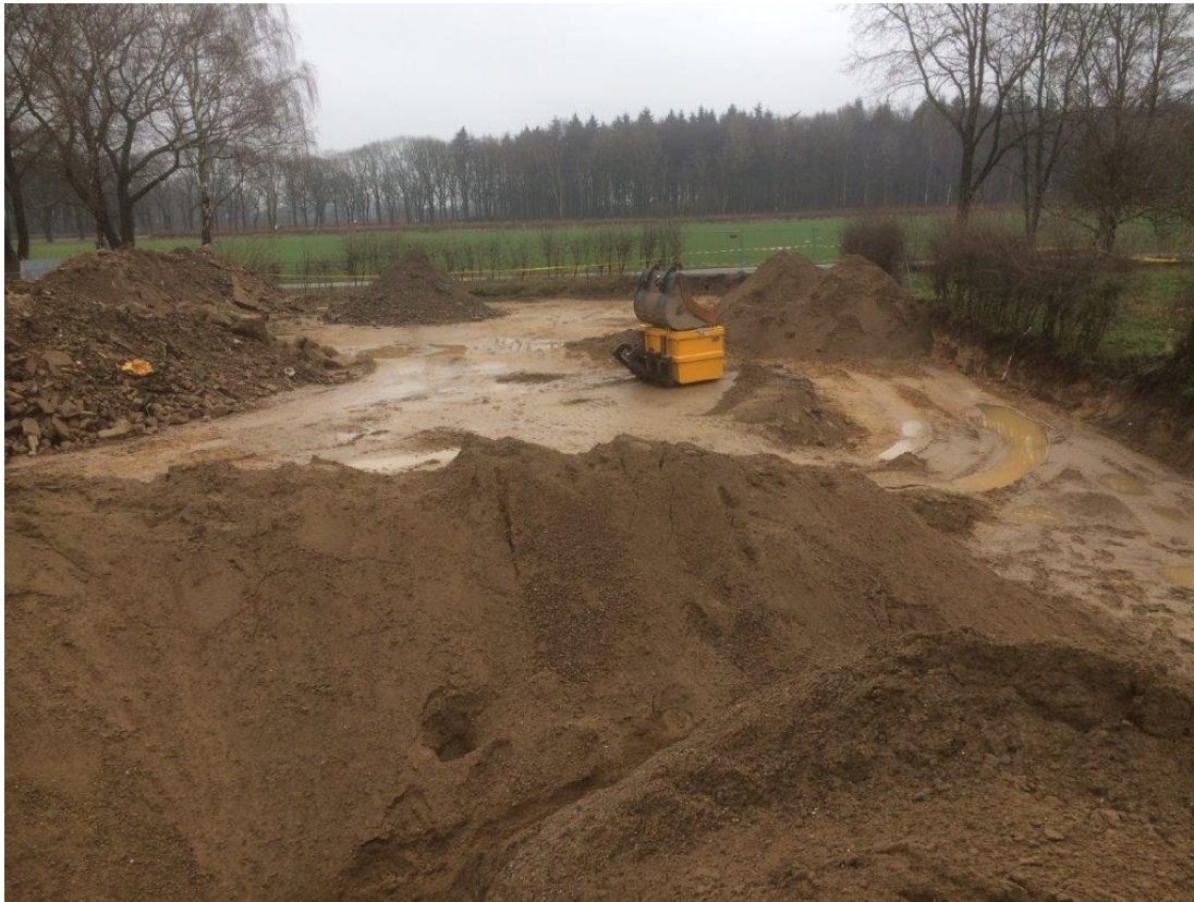
Foto 13: Aan rechterzijde ontgraven puinpad + depot gezeefde grond. Aan linker zijde grove fractie ten behoeve van afvoer
