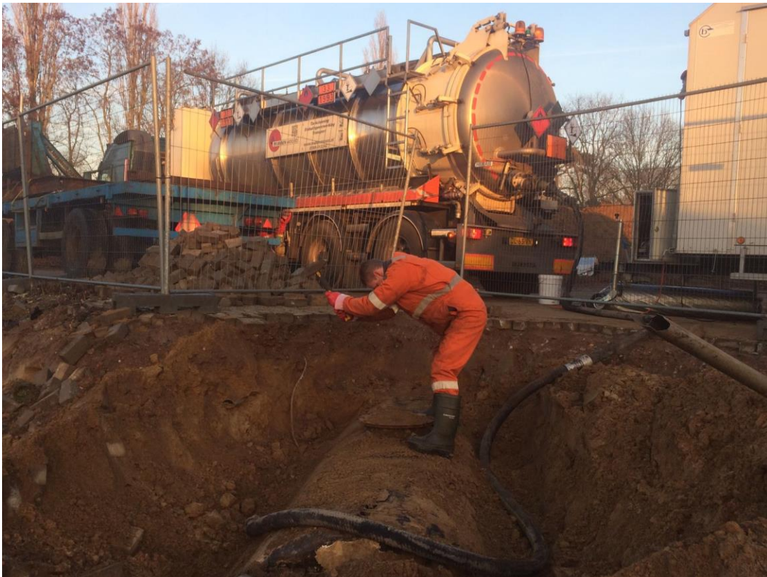
Foto 10: Reiniging aangetroffen ondergrondse tank
