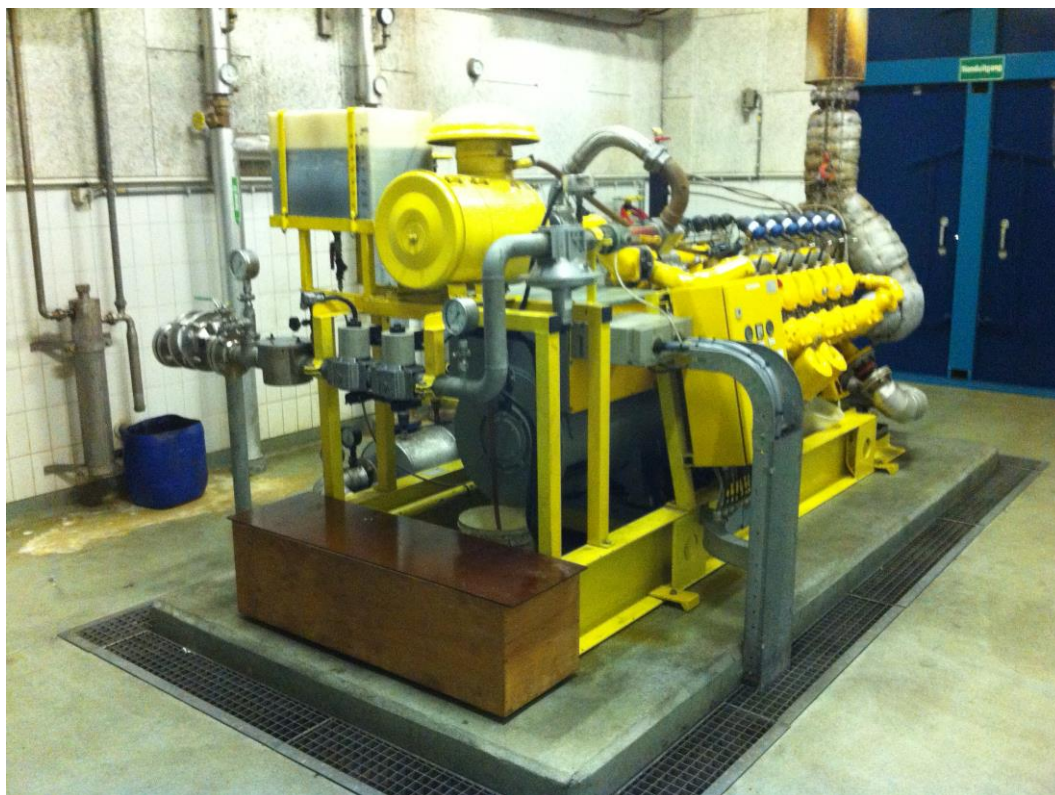
Foto: Bestaande gasmotor.
