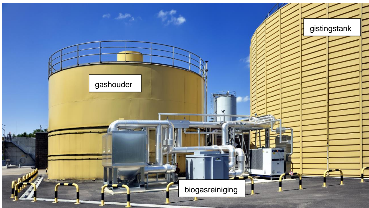
Foto: biogasreinigingsinstallatie.
