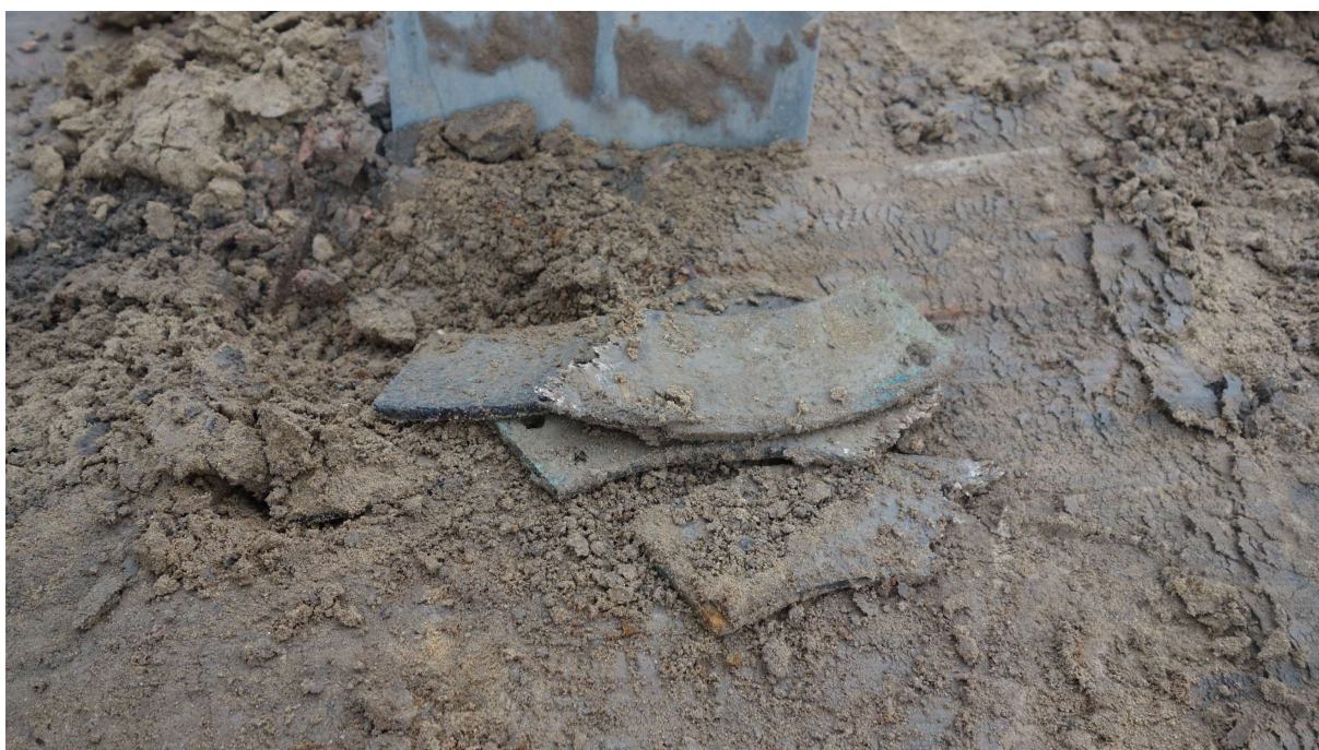
Sanering deelgebied 2A: vondst asbestverdacht materiaal (pakking)
