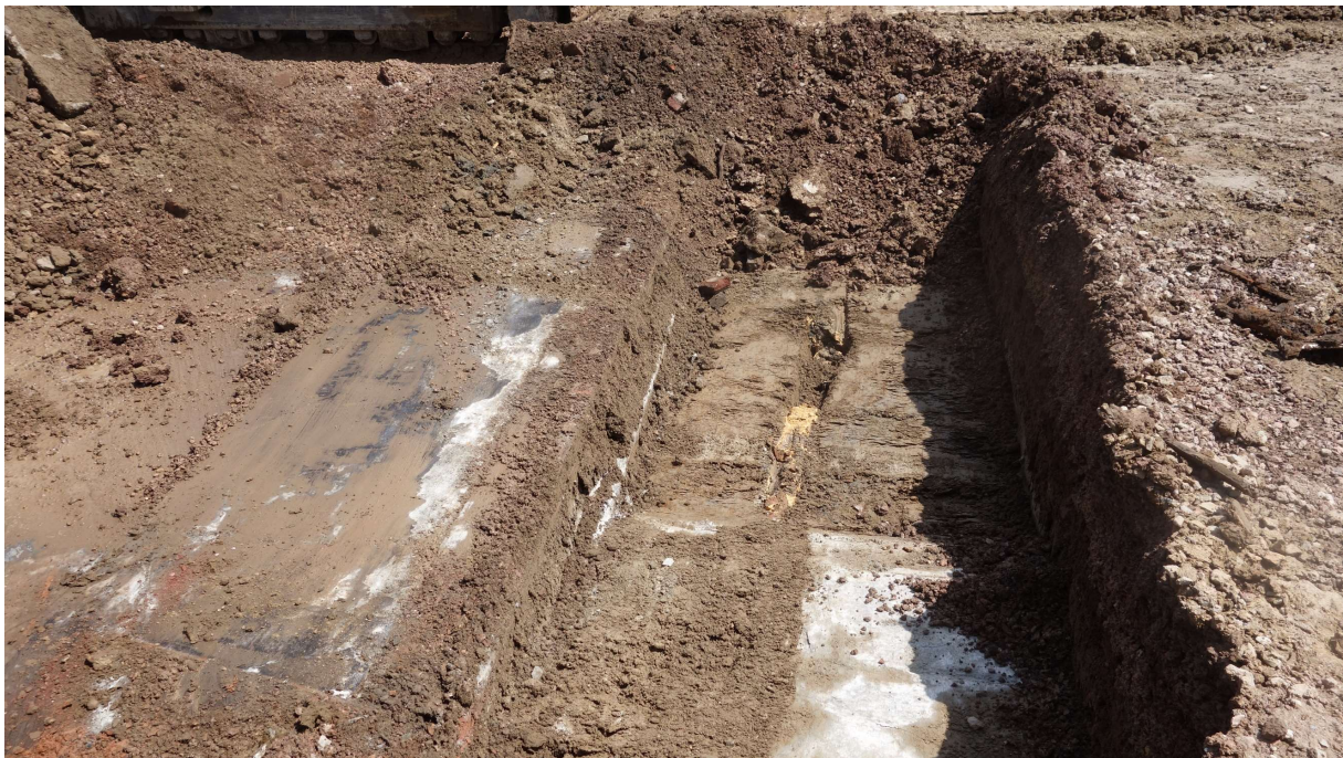
Sanering deelgebied 2A: ontgraving zandlaag tot vloeren en funderingen
