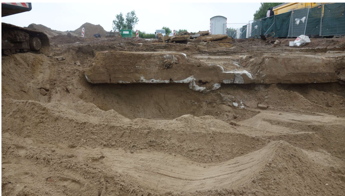
Sanering deelgebied 2A: sloop vloeren en funderingen na verwijderen zandlaag met asbest
