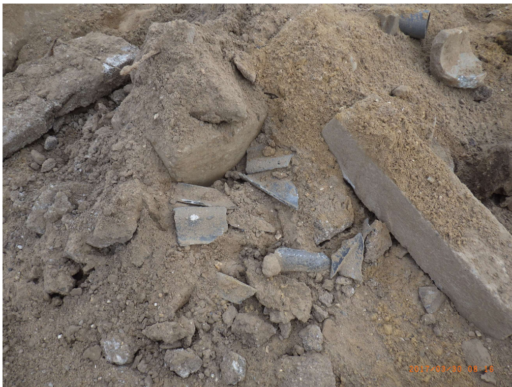
Sanering deelgebied 7B1: vondst asbestverdacht materiaal
