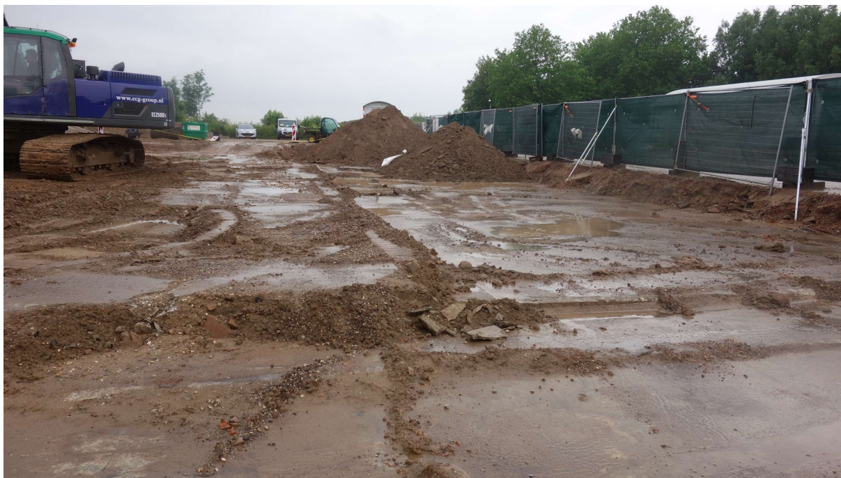
Sanering deelgebied 2A: zandlaag ontgraven met achteraan depots met asbest verontreinigde grond (partijen NT-01 (vooraan) en NT-02)
