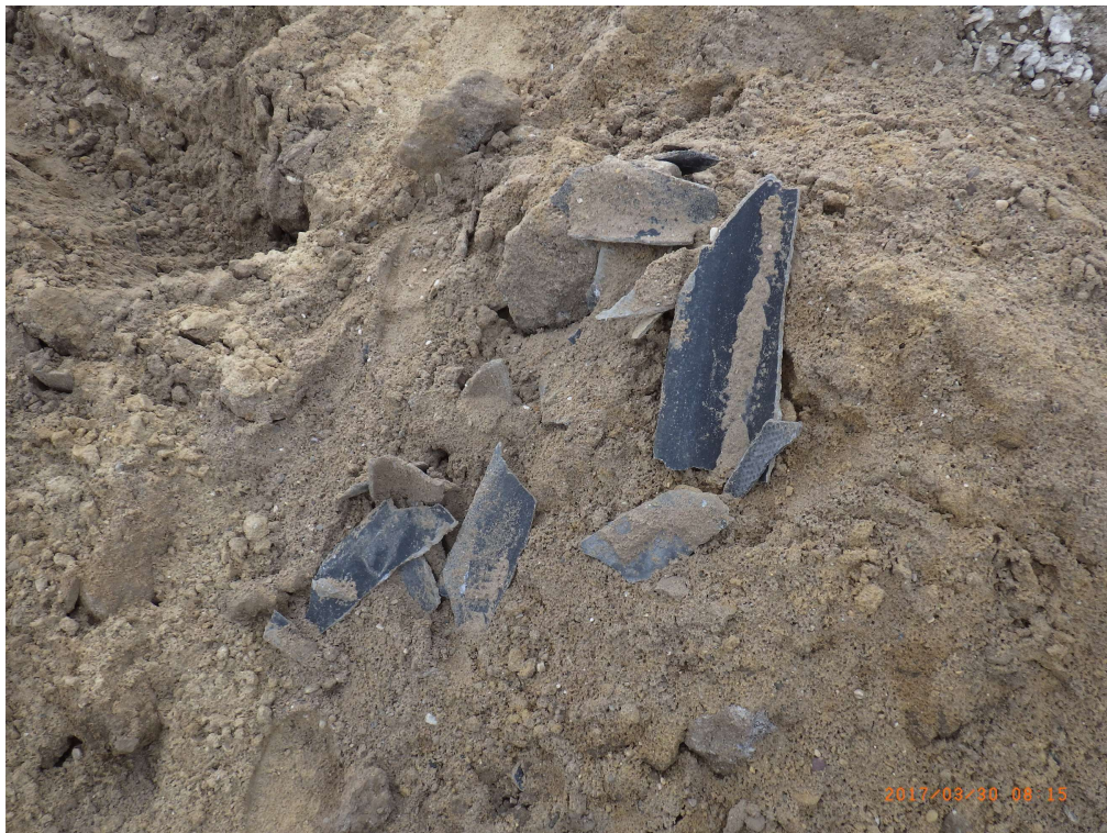
Sanering deelgebied 7B1: vondst asbestverdacht materiaal
