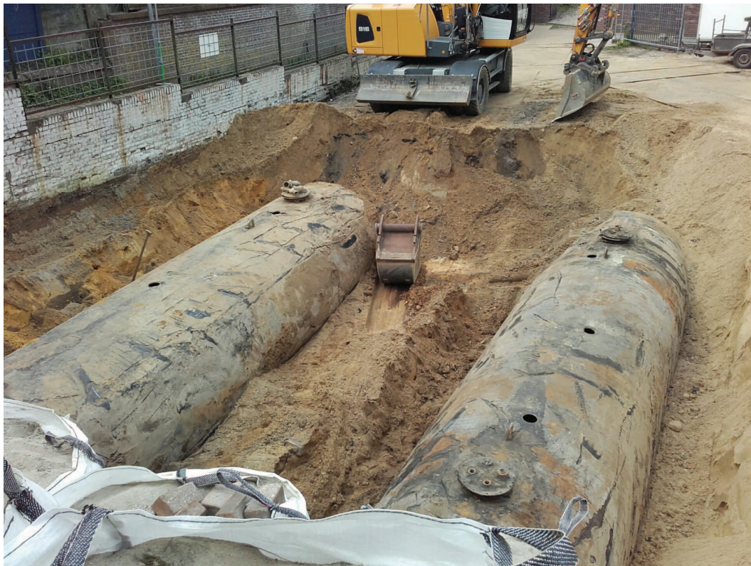
Foto 2: Vrijgraven ondergrondse brandstoftanks.
