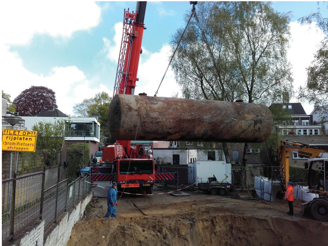
Foto 3: Verwijderen brandstoftanks.
