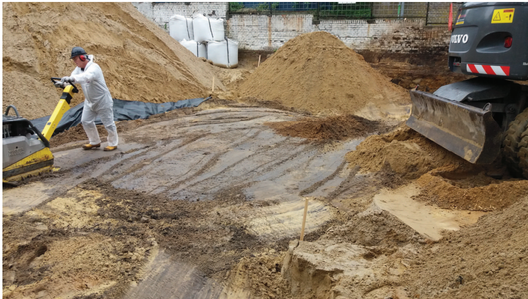
Foto 5: Aanvullen ontgraving en aanbrengen signaleringsdoek.
