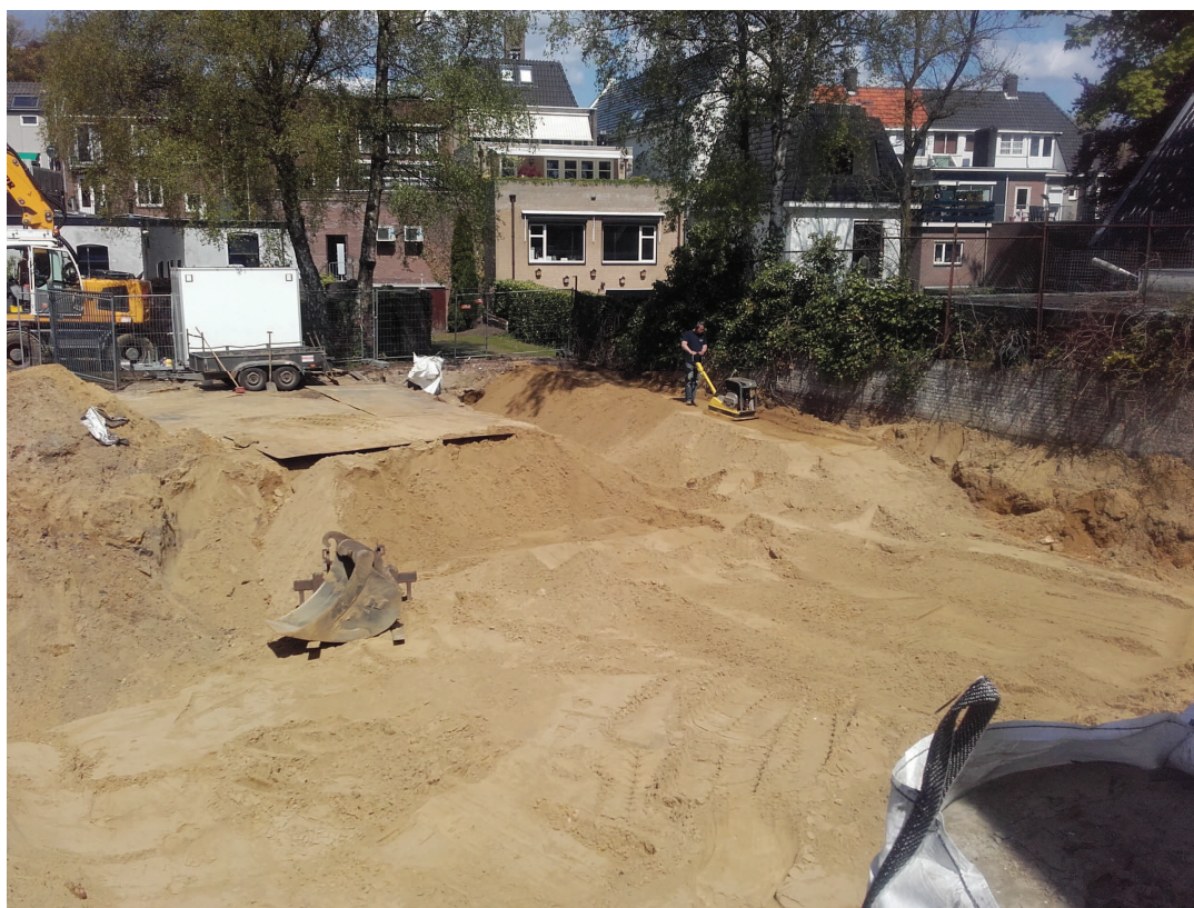
Foto 4: Aanvullen ontgraving.
