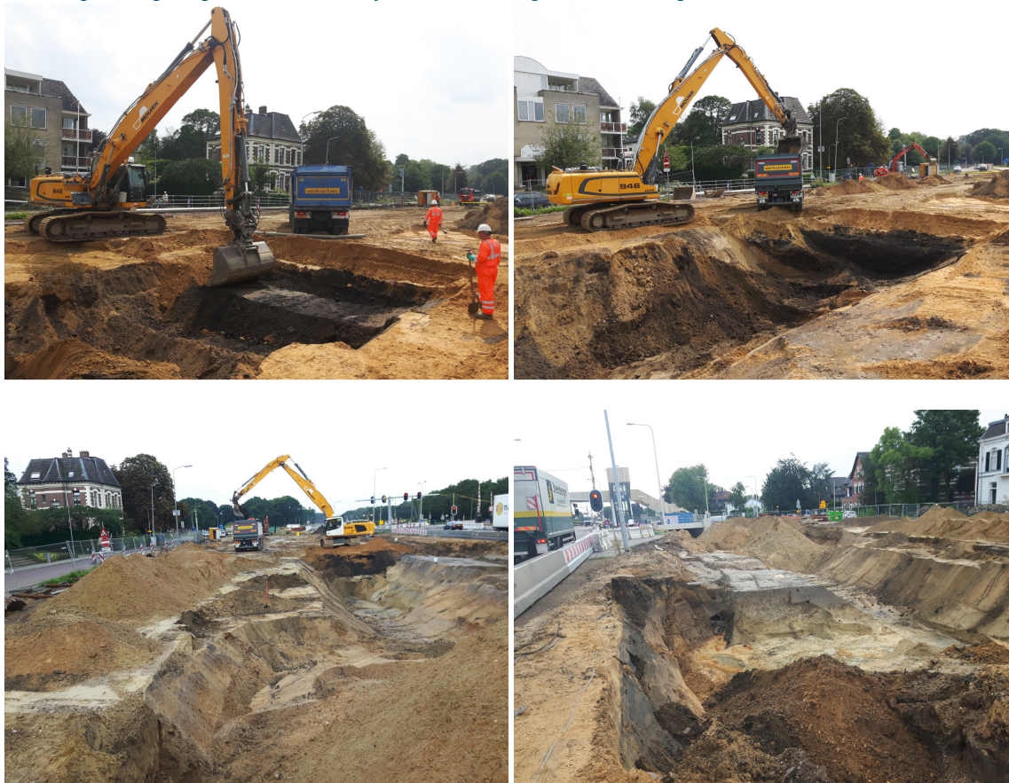
Afbeelding 4.3 Ontgraving fase 1 inclusief verwijderen van de kolengruishoudende laag
