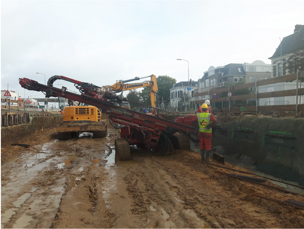
Afbeelding 4.7 Aanbrengen groutankers
