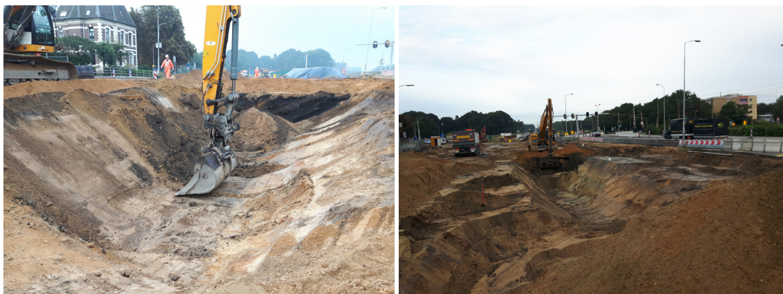
Afbeelding 4.11 Profiel van ontgraving kolengruishoudende laag
