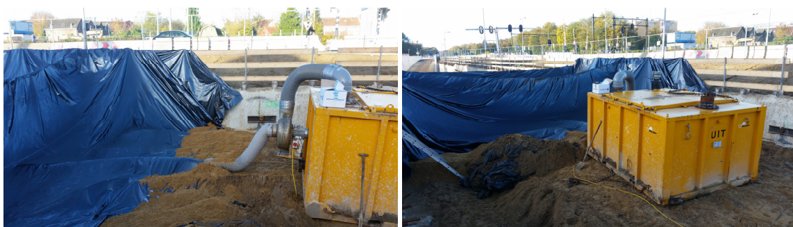
Afbeelding 4.10 Afzuiginstallatie saneringswerkzaamheden fase 3
